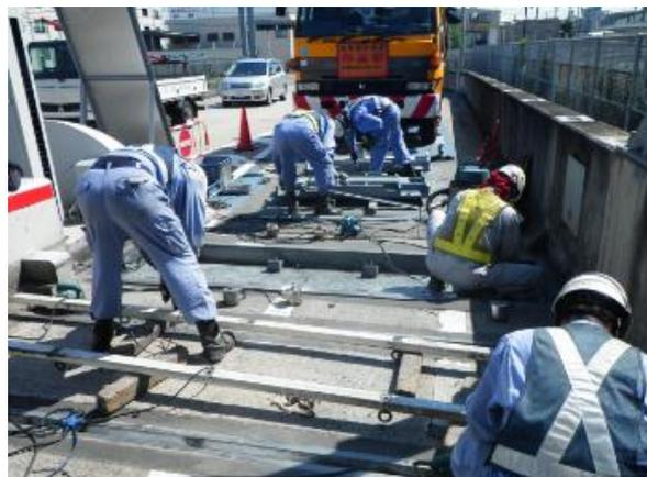
軸重計測設備 定期点検
