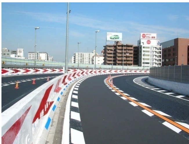
汐見カーブ下り（滑り止め舗装・LED点滅灯）
