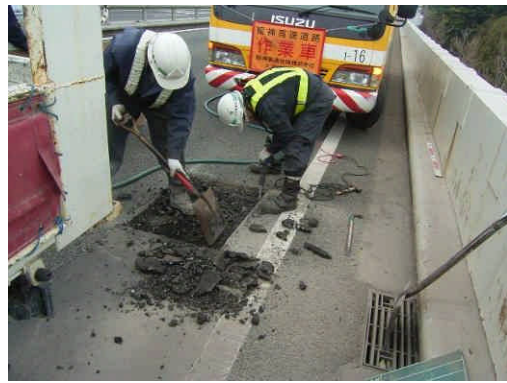
舗装補修状況
