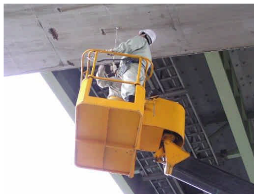
構造物点検作業
