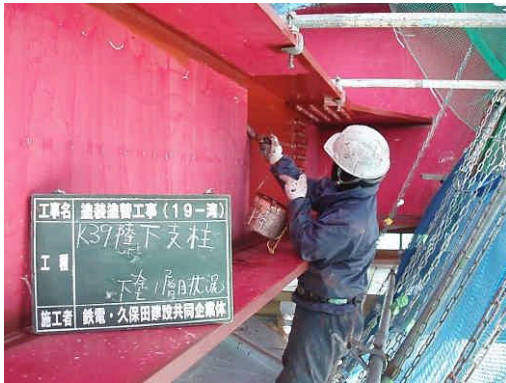
塗装塗替工事状況
