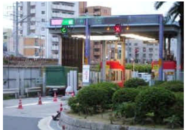
車線規制実施時（右側を閉鎖）
