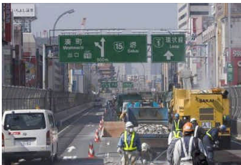
全面通行止め工事による工事集約
