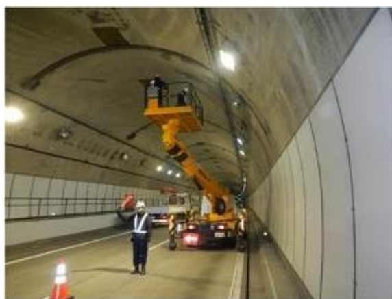
トンネル 定期点検
