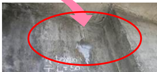
点検時応急措置(はく離、遊離石灰の補修)
