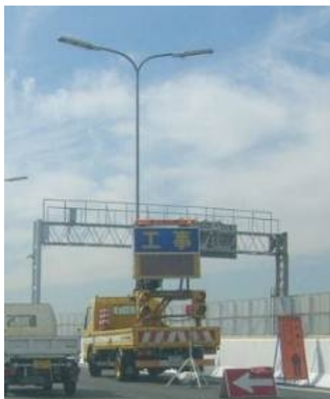
照明柱取替前
