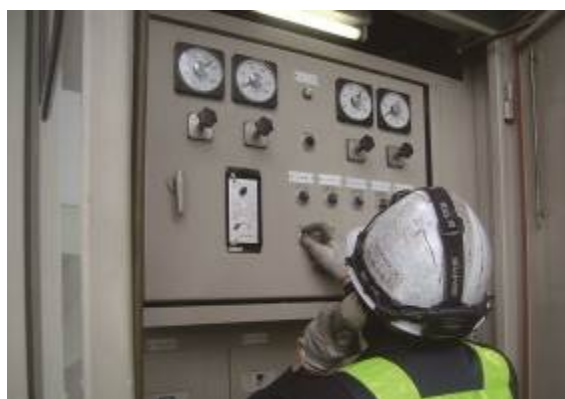
定期点検（変電塔）
