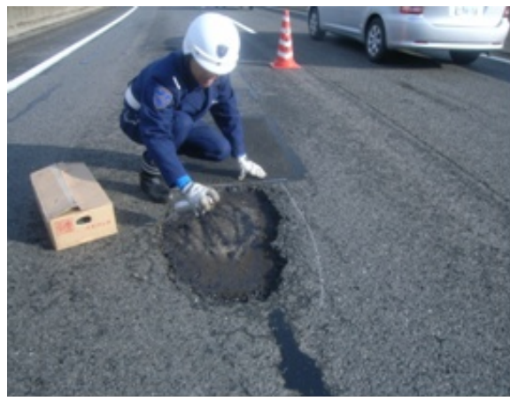
ポットホールの緊急対応の様子
