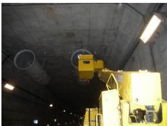
トンネル換気設備 定期点検
