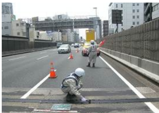
日常点検（路上）
