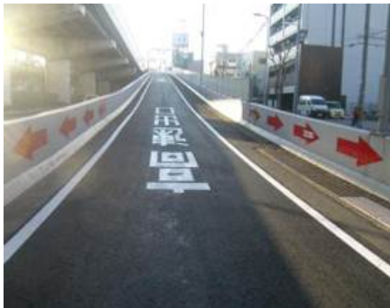
高欄側面矢印表示、路面表示等の設置 （13号東大阪線 高井田出口）
