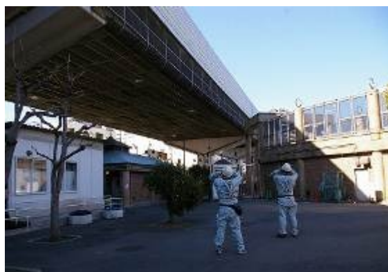
日常点検（路下）
