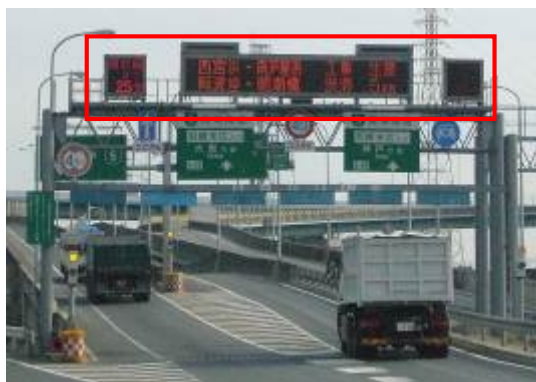
道路情報板取替前
