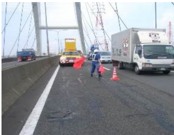
ポットホールの緊急対応の様子
