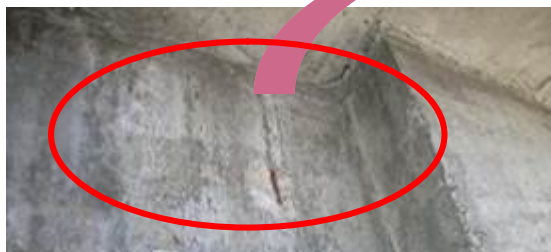
点検時応急措置(はく離、遊離石灰の補修)
