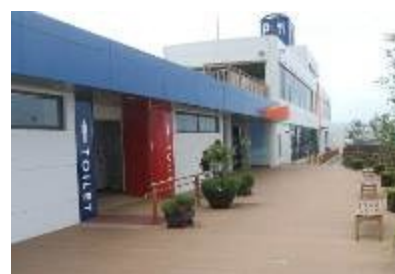
ウッドデッキの設置
