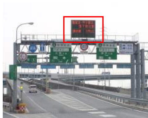
道路情報板取替後
