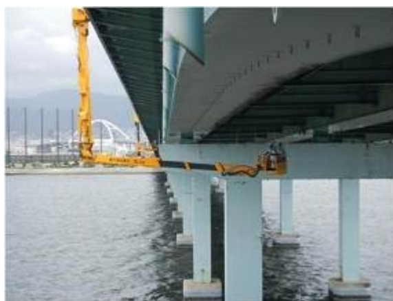
橋梁 定期点検
