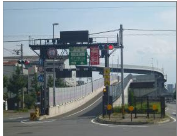
「有料」表示の自発光式注意喚起看板の設置 （8号京都線 上鳥羽入口）
