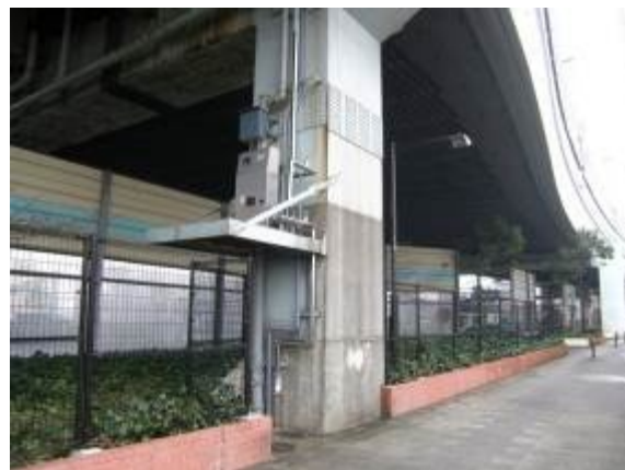
給水設備 取替後
