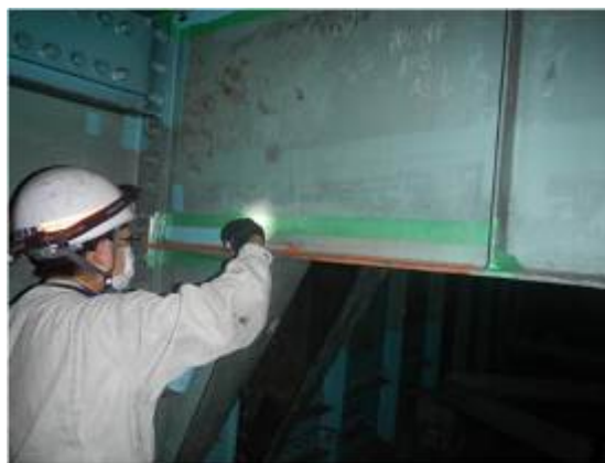
点検時応急措置(塗装補修)
