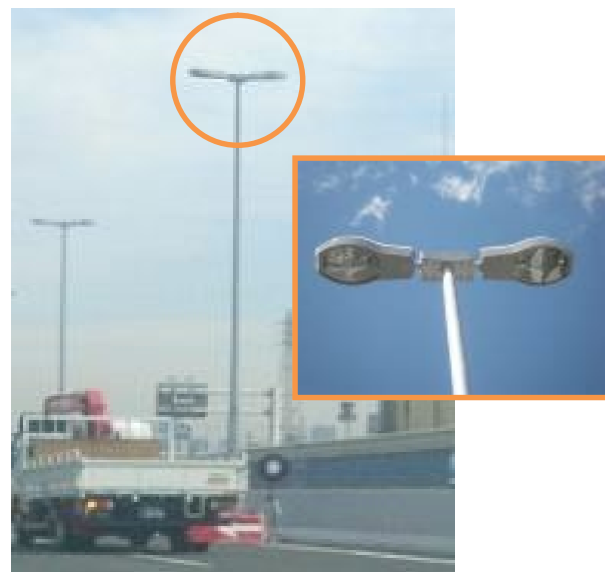
照明柱取替後
