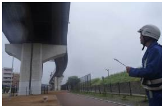
高架下点検及び構造物日常点検
