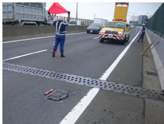
ポットホールの緊急対応の様子
