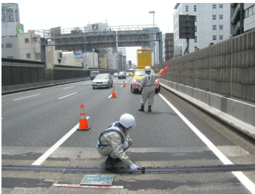
日常点検（路上）
