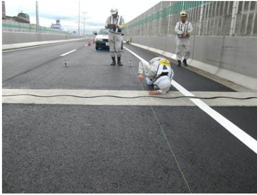
施工後の平坦性確認状況
