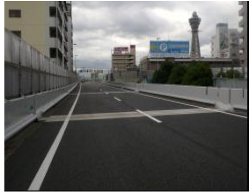
舗装・伸縮継手一体施工完了状況
