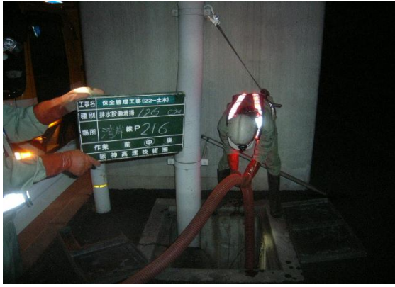
排水設備清掃作業（路下集水樹）
