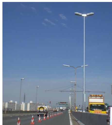
照明柱取替後
