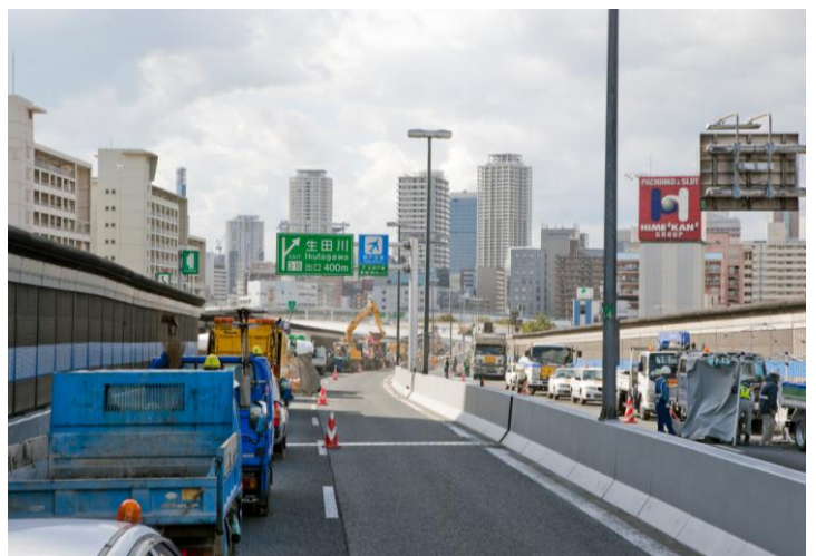
工事の実施状況
