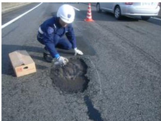
ポットホールの緊急対応の様子
