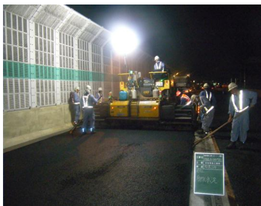
舗装打替作業
