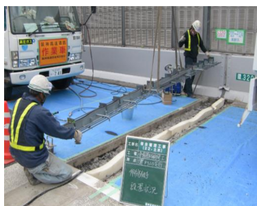
伸縮継手取替え
