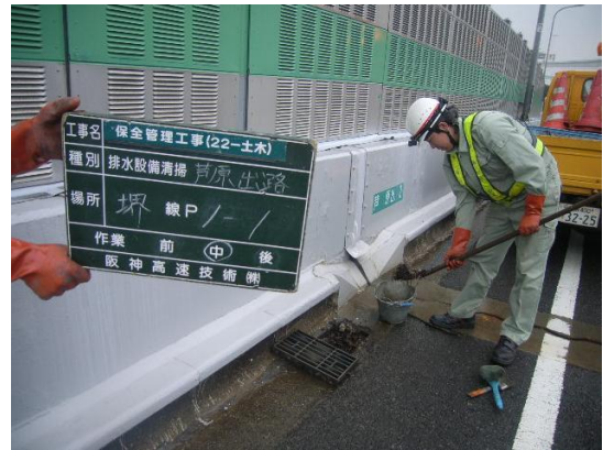
排水設備清掃作業（路上集水樹）
