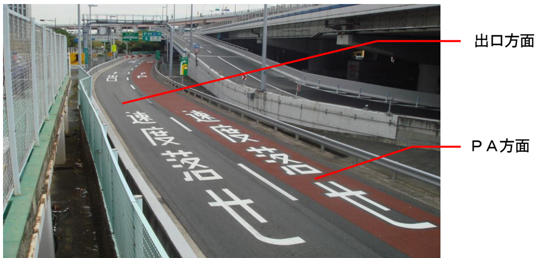
PA案内カラー舗装（京橋PA）
