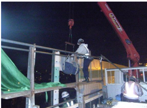
遮音壁取換工事
