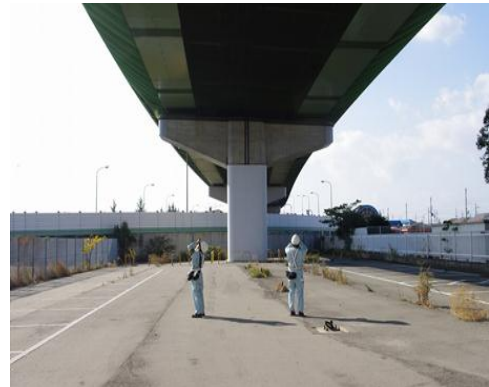
日常点検（路下）
