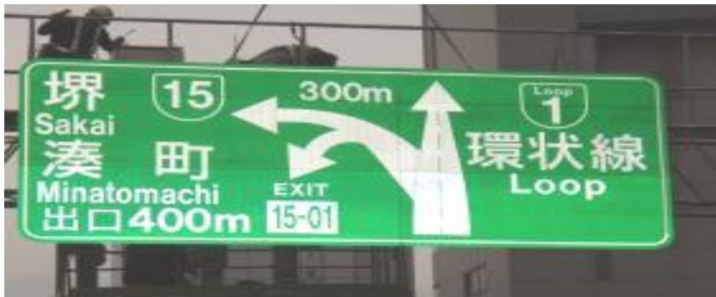
多車線分岐部の案内標識改善 改良後
