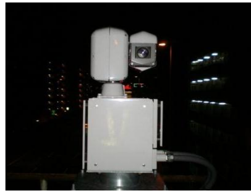
交通流監視カメラ更新後
