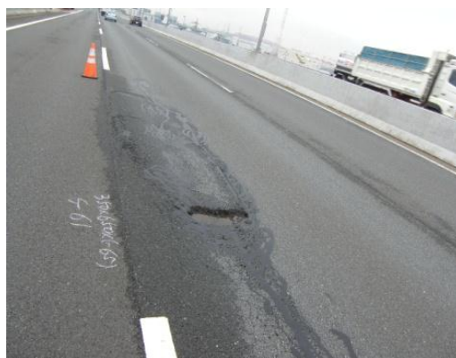
路面損傷状況 舗装打替作業
