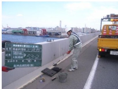
清掃作業（排水桝清掃）
