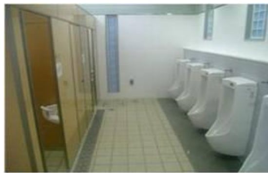
京橋（東行）PA（H20.9改修）
