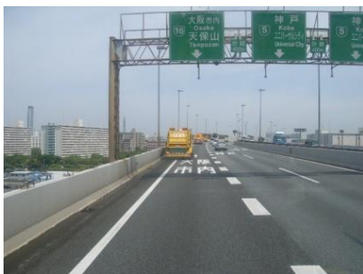
清掃作業（路面清掃）
