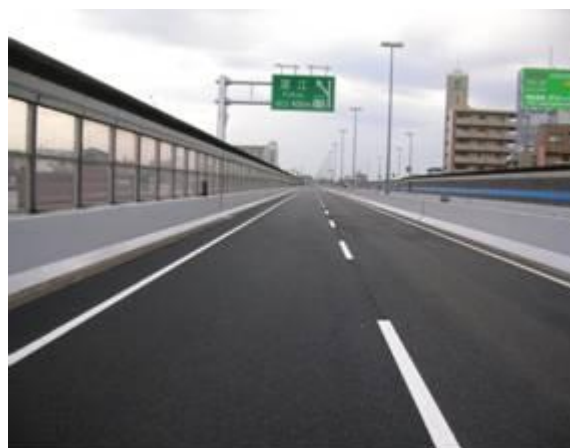
桁連結箇所の走行性改善
