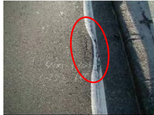
補修の必要な状態の事例
