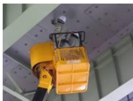
構造物点検作業
