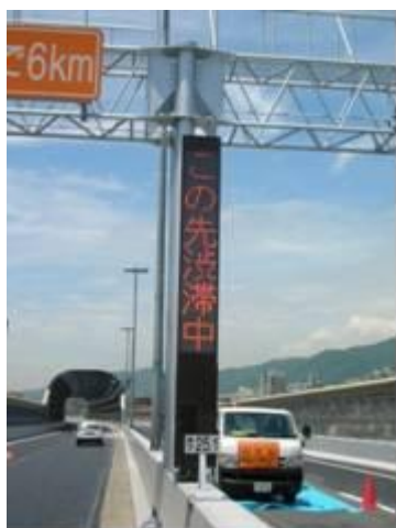
LED表示板設置
