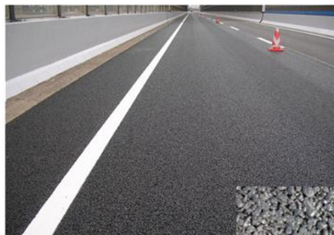
※舗装新材料採用による 耐水性・耐流動性の向上
