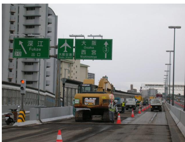
工事の実施状況
