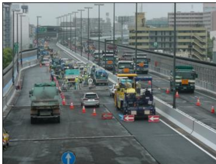
全面通行止め工事による工事集約
