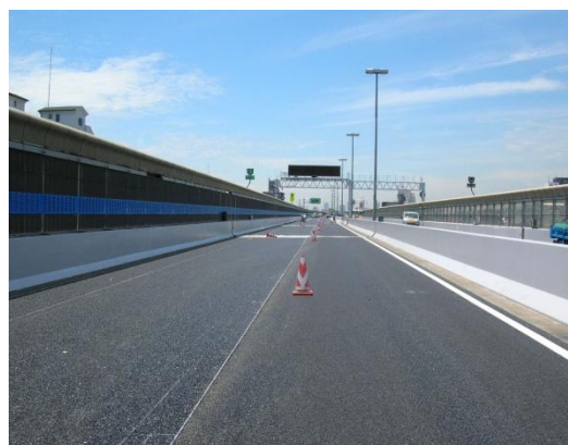
遮音壁ラインの設置
