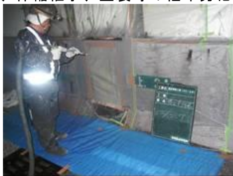
塗装塗替工事
