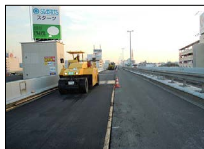
① 橋梁間を連続で舗装
