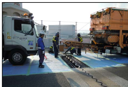
② 舗装敷設後、ジョイントを施工 (手順)
