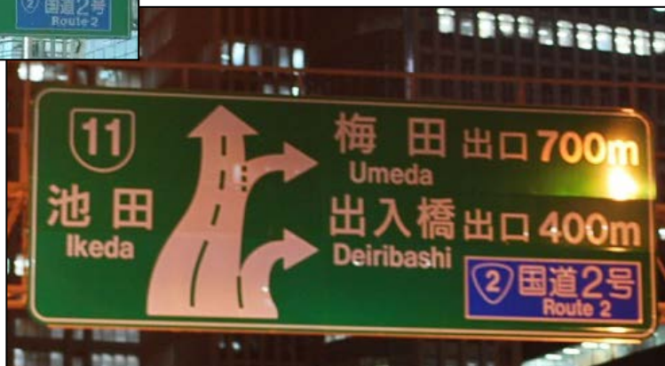
《CS向上施策(車線構成が明示された案内標識:左上は改善前)》
