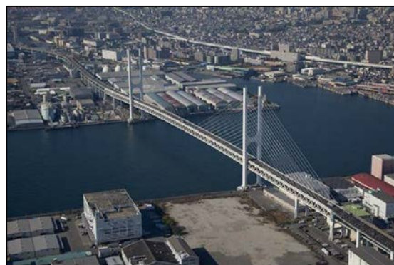
《長大橋(東神戸大橋)》
