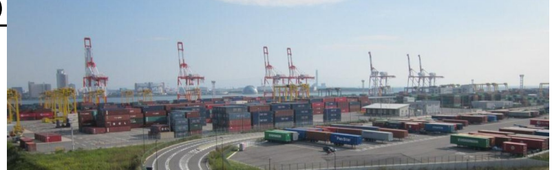
夢洲コンテナターミナル
