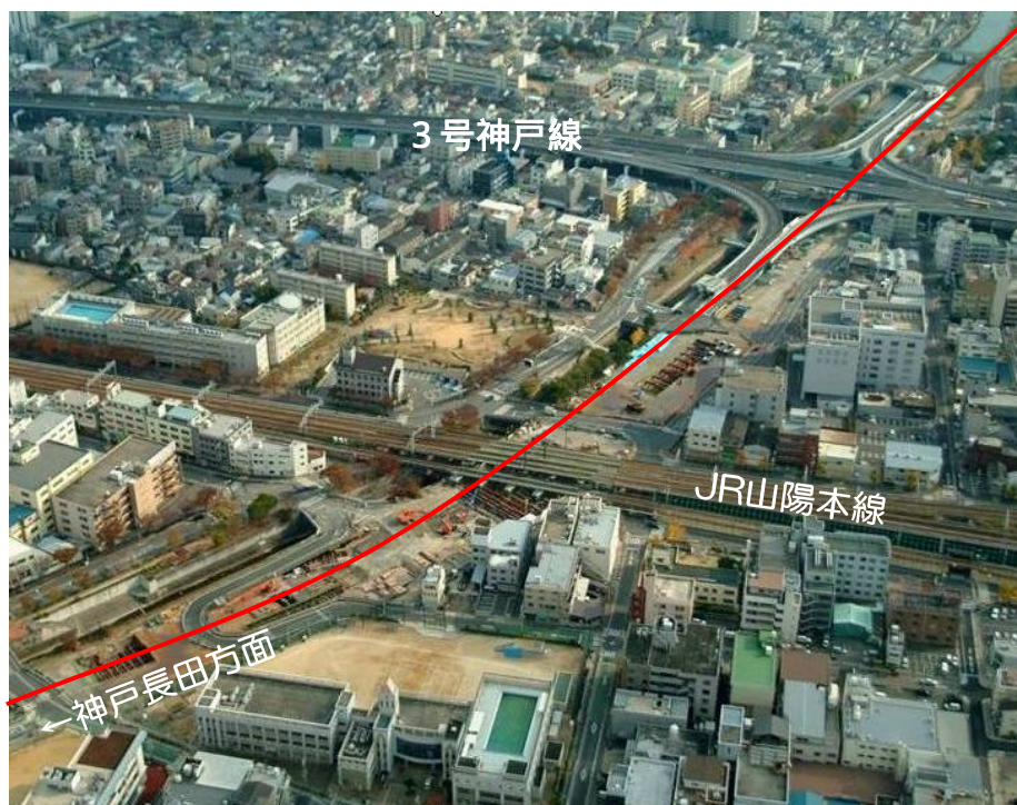
工事中区間の状況
