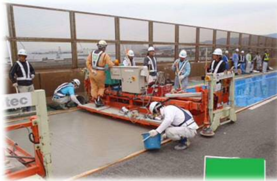
SFRC施工の状況
