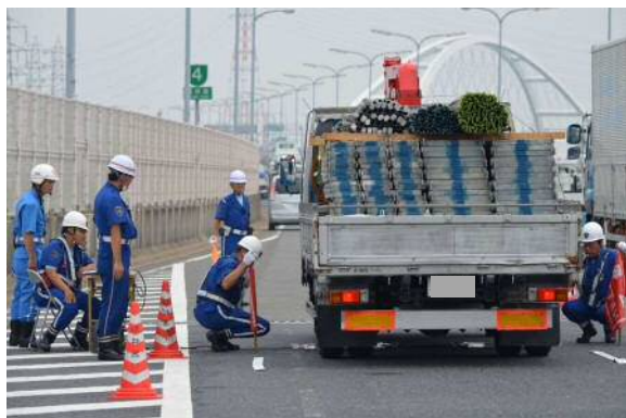
警察との合同の重量違反車両取締り状況
