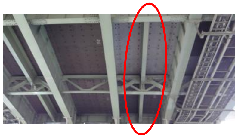
写真－縦桁補強(イメージ)
