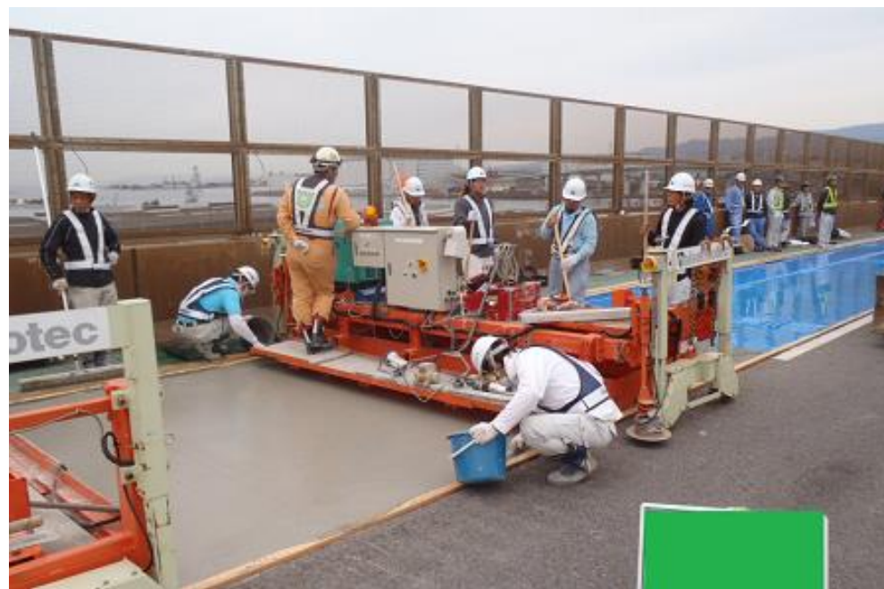
写真一 SFRC施工状況
