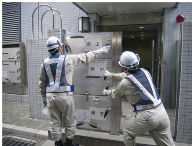
防潮堤設置作業(手動式)
