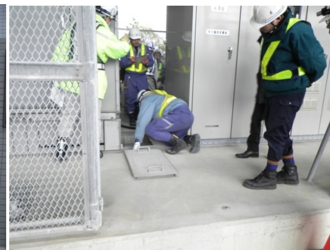
通信塔外で障害調査作業
