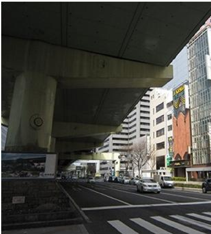
対象橋梁全景写真
