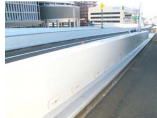
鋼製高欄外観
