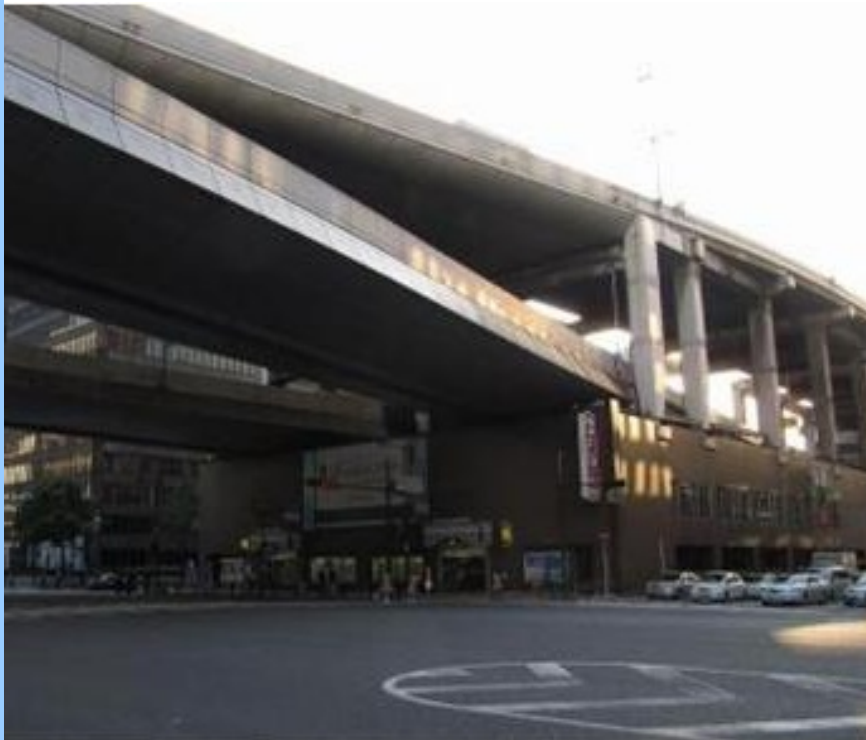
船場センタービル (ビル躯体を基礎とした構造)
