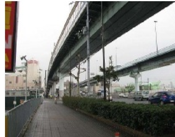
対象橋梁全景
