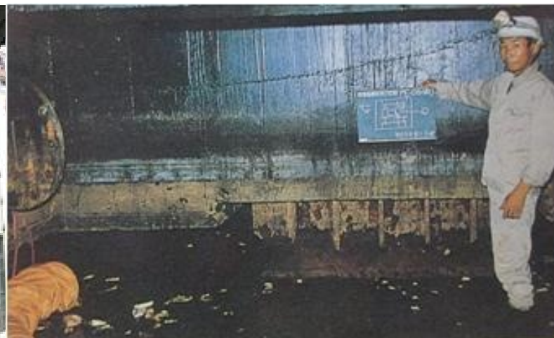
鋼製フーチング外観写真
