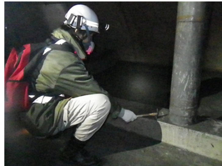
鋼材を支持する取付部の点検
