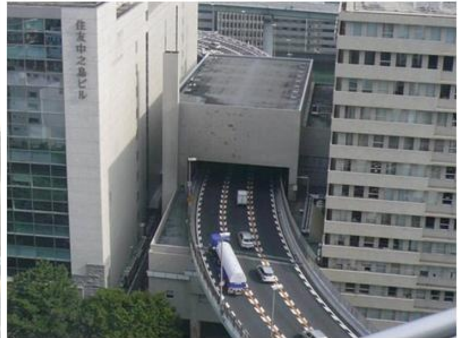
朝日新聞社ビル (ビル躯体を基礎とした構造)
