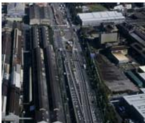
島屋工区の現状
