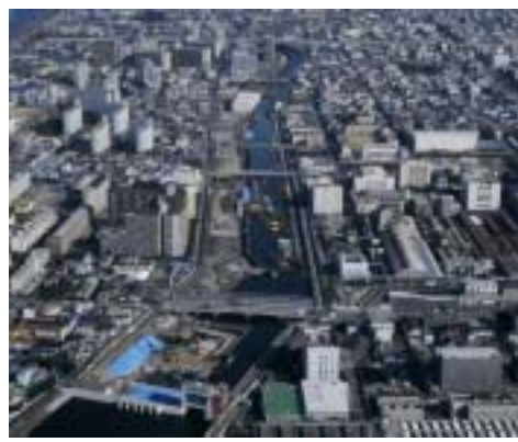
正蓮寺川工区の現状
