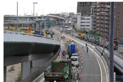
3号神戸線 工事状況(H22.11.9～11.17)
