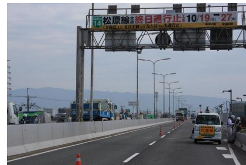
14号松原線 工事状況(H22.10.19～10.27)
