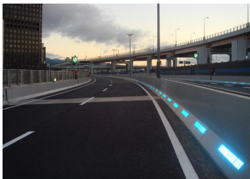
カーブ区間の視線誘導標設置
