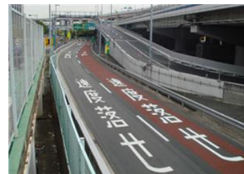
京橋PA(東行)カラー舗装
