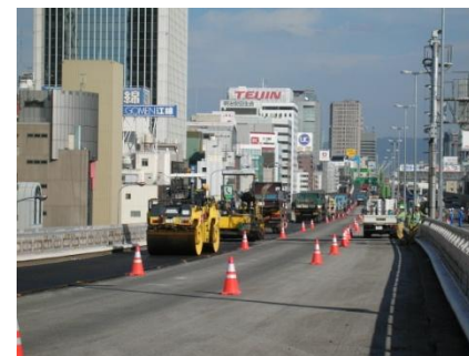
〔16号大阪港線工事状況〕
