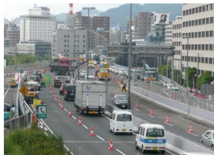
〔3号神戸線(湊川～京橋間)工事状況〕
