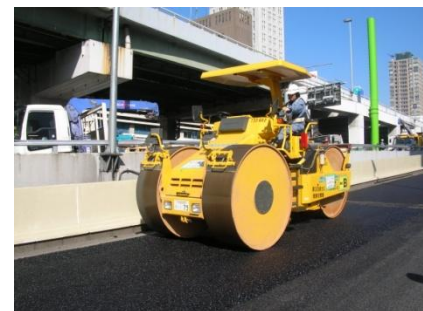
〔高機能舗装の打替え〕
