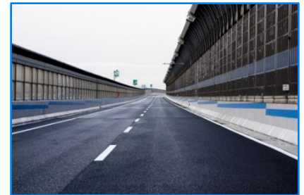
（深江付近に設置した水平標示）
