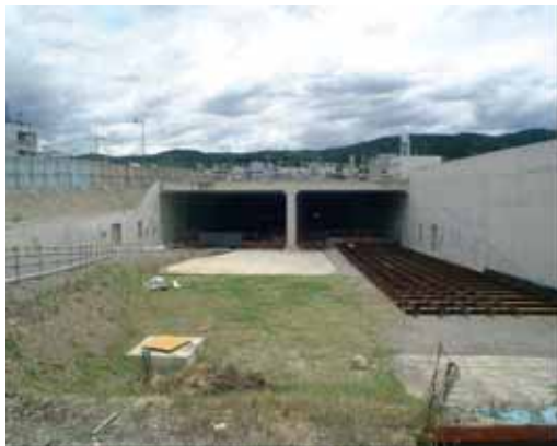
開削トンネル坑口
