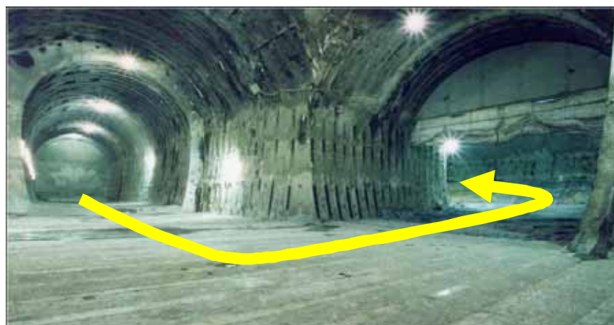
シールドマシン転回部
