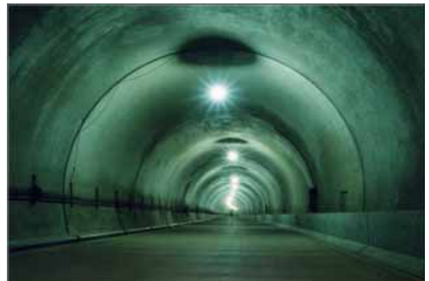
トンネル覆工状況
