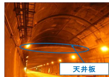
新神戸トンネル天井板設置状況
