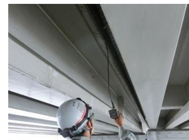
ファイバースコープによる狭隘部の点検
