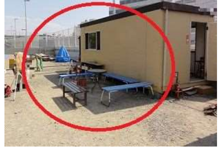
× 屋外休憩所の不良
