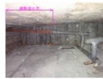
⑥ 鋼製排水管の腐食
