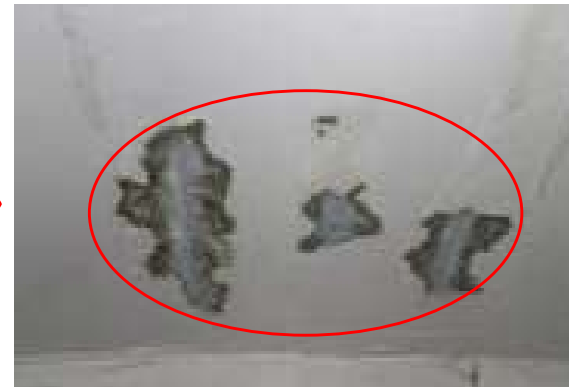
応急措置の実施例 (コンクリート構造物の浮等の除去・表面防護材の塗布)
