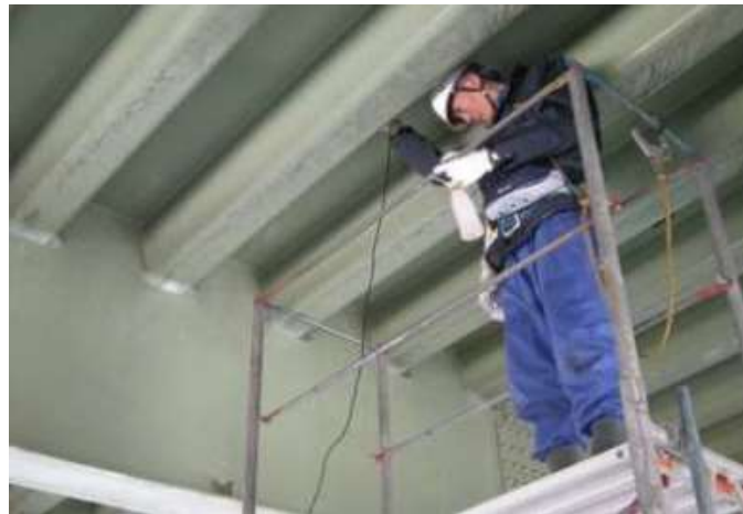
超音波を用いた桁下からのき裂点検状況
