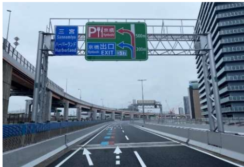
京橋出口・京橋PA案内標識・路面標示実施例
