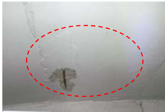
応急措置の実施例 (コンクリート構造物の浮等の除去・表面防護材の塗布)
