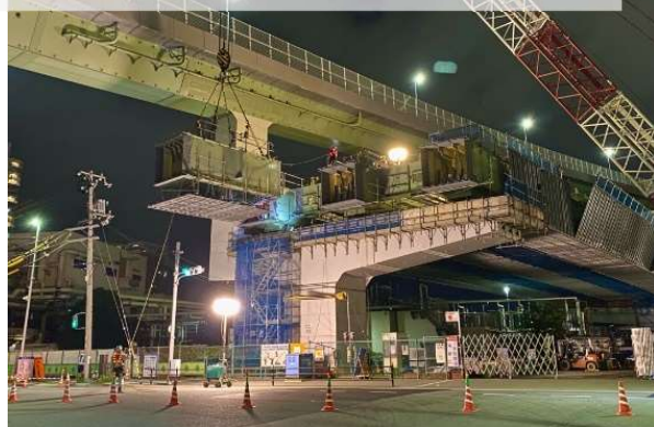
小ブロックでの桁架設状況
