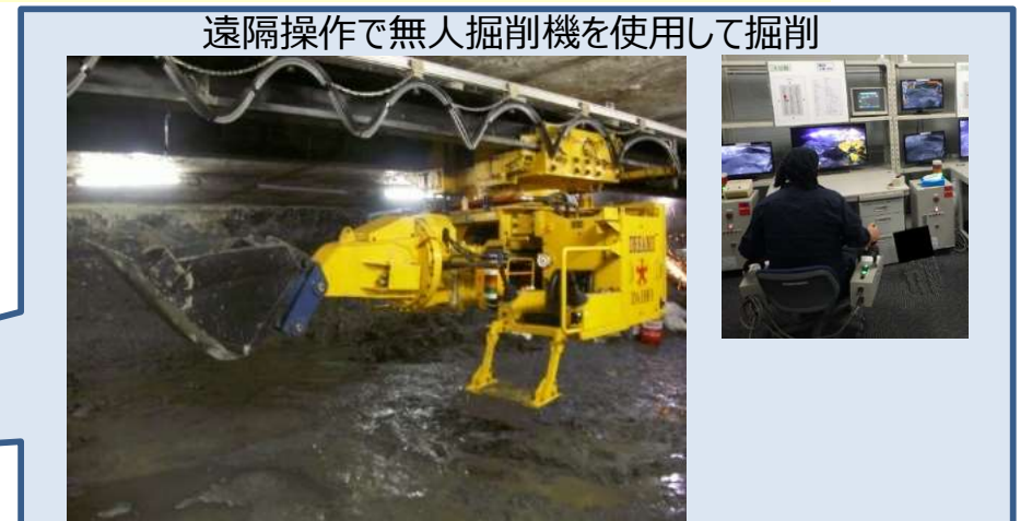
無人掘削機時にレーザースキャナを用いた掘削管理
