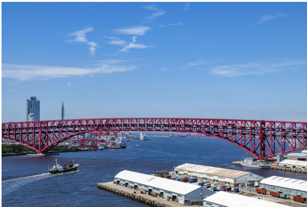
16号大阪港線（上路）・4号湾岸線（下路） 港大橋
