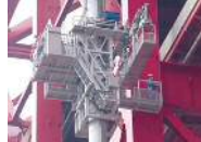
主構内方向側まで安定した足場から接近
