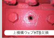
上構横ウェブHTB欠損
