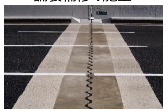
新しい伸縮継手への交換
