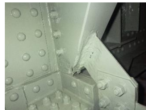
桁端部の重防食塗装
