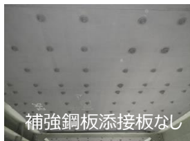
補強鋼板ハンチ部なし
