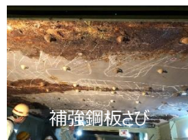
補強鋼板添接板なし
