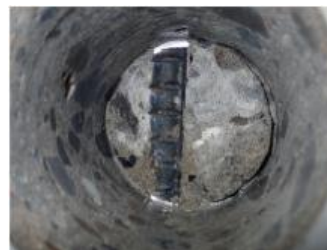
鉄筋腐食調査
