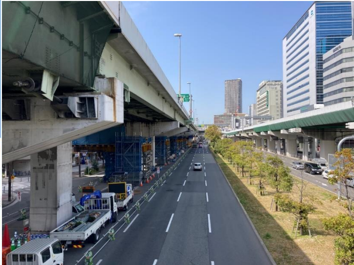
中央大通（本線）の固定規制 （大阪湾方面、2021年3月19日撮影）
