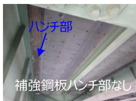
補強鋼板添接板なし
