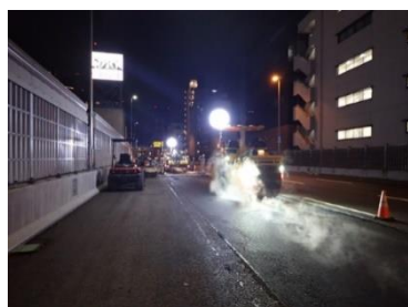
夜間の車線規制工事 (騒音が少ない工種・工法に限定)
