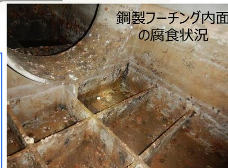
鋼製フーチング内面の腐食状況
