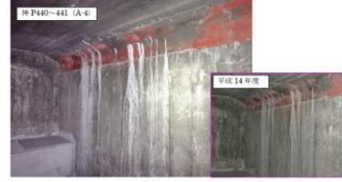
③ 箱桁内面打継目の遊離石灰
