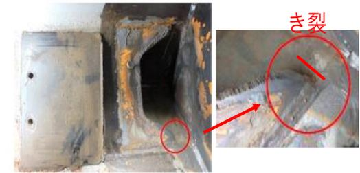
コーナプレート溶接部を起点とした主桁下フランジのき裂状況
