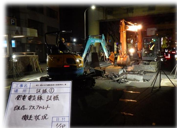
写真 埋設物試掘調査状況
