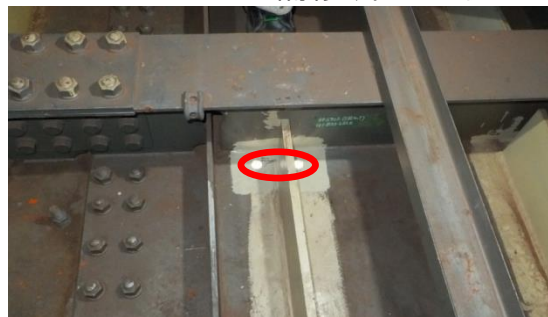
ストップホール補修済みの状況
