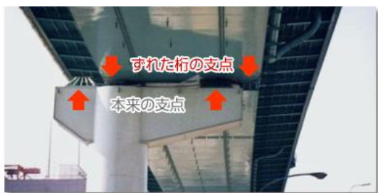
【参考】震災時の桁のずれ
