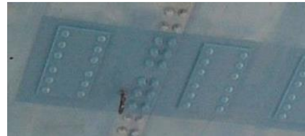
当て板設置済みの状況
