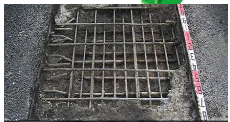
陥没したコンクリート床版
