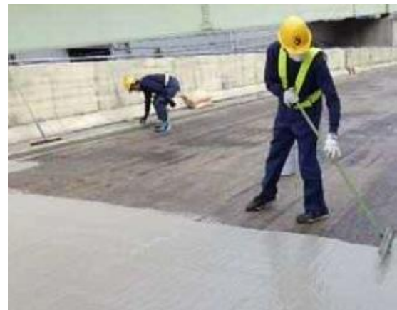
試験施工状況
