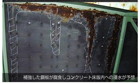
陥没したコンクリート床版
