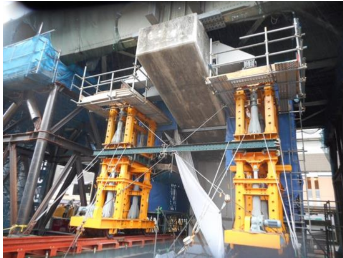
〔STEP③：荷受けジャッキ設置完了〕
