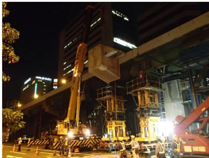
〔STEP⑤：切断ブロックの撤去（梁の吊り降ろし）〕
