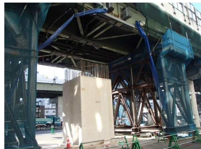
〔STEP⑥：橋脚梁部の撤去完了〕
