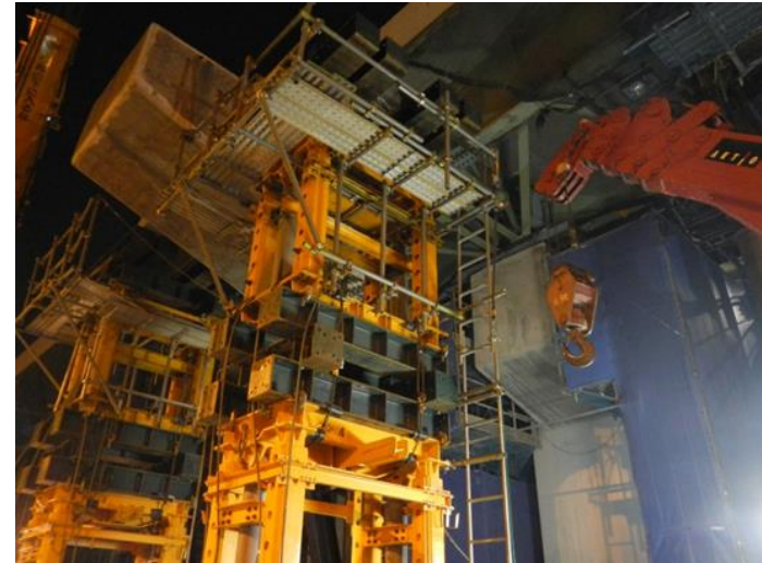
〔STEP④：切断した梁の移動〕
