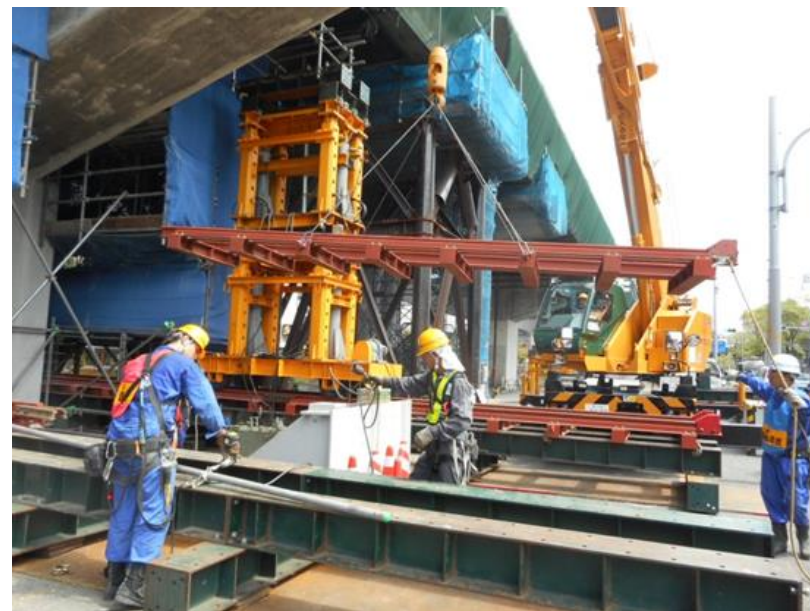
〔STEP②: 荷受けジャッキの組立〕
