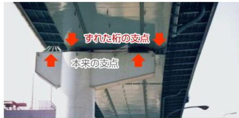
震災時の桁のずれ
