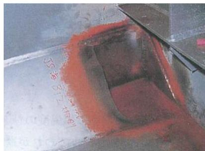
き裂部の溶接部を除去する開口部を設け、防食のためプレートを設置
