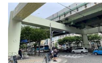
橋脚塗装状況
