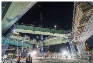
橋梁架設工事
