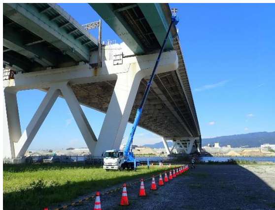
地方公共団体が管理する橋梁の定期点検
