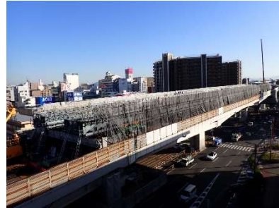
仮設桁の設置
