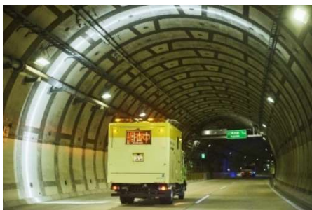
ドクターバト2.0による路面・トンネルの点検
