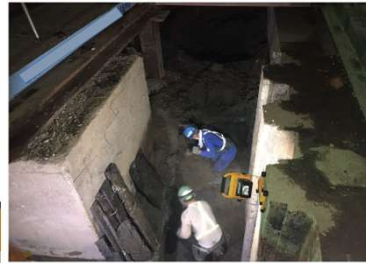
橋脚基礎付近の掘削
