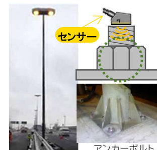
照明等の柱基部 アンカーボルト劣化判定装置等の非破壊検査技術
