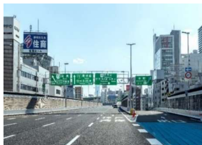
舗装等補修状況
