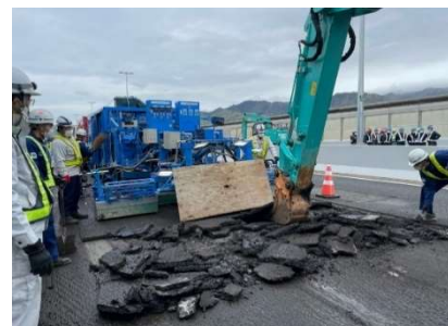
IH式鋼床版舗装撤去工法
