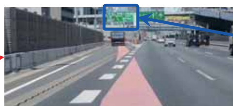
《参考》1号環状線の信濃橋出口・西船場JCTの連続分岐部における、カラー舗装の実施例
