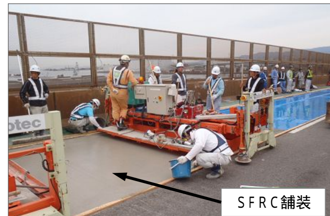
〔SFRC舗装施工状況〕
