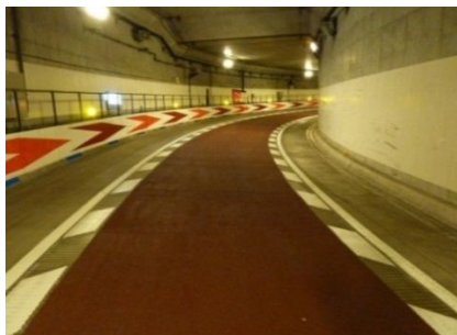
〔滑り止め舗装(神山渡りカーブ)〕
