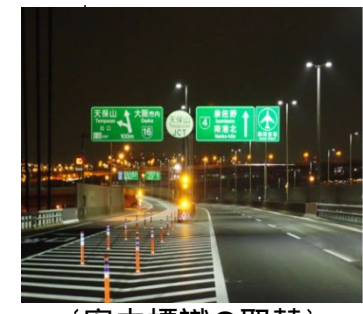
(案内標識の取替) (超高輝度反射板への取替) 14
