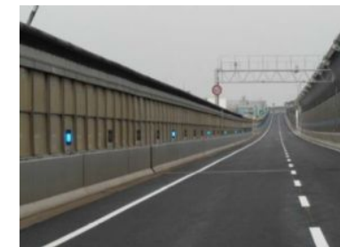
(速度回復誘導灯の設置) (深江サグ部)
