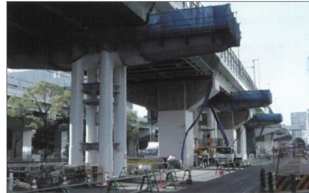
〔西船場JCT(12基施工中)〕
