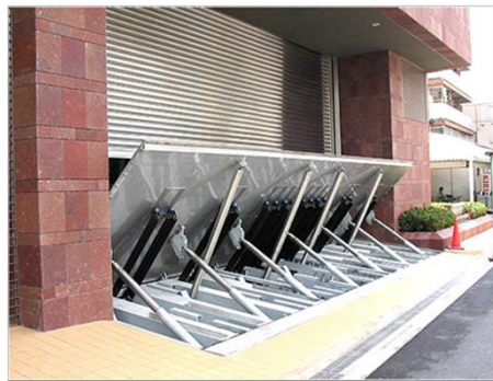
防潮板の設置
