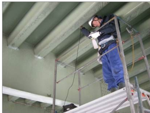
〔鋼床版下面からの点検状況〕
