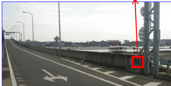
〔津波注意喚起板（海拔表示）一例〕
