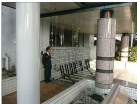
〔防潮板の設置〕
