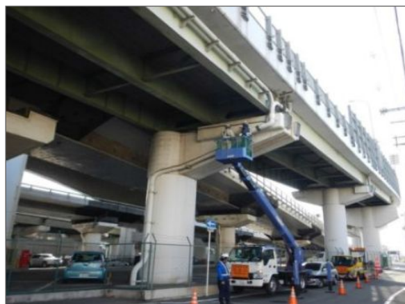
〔高所作業車による近接点検〕
