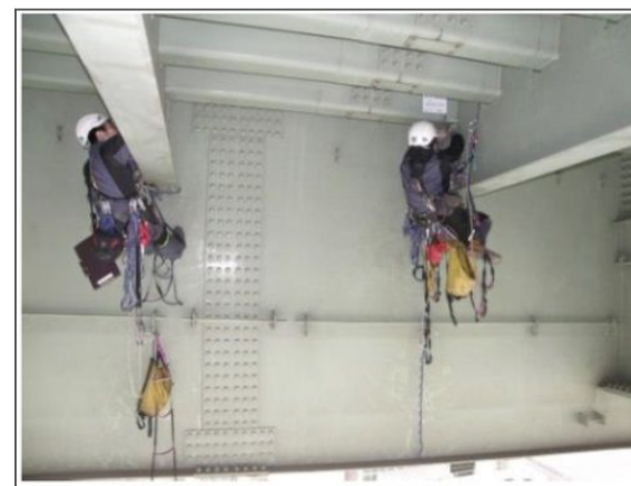
〔ロープアクセスによる近接点検〕
