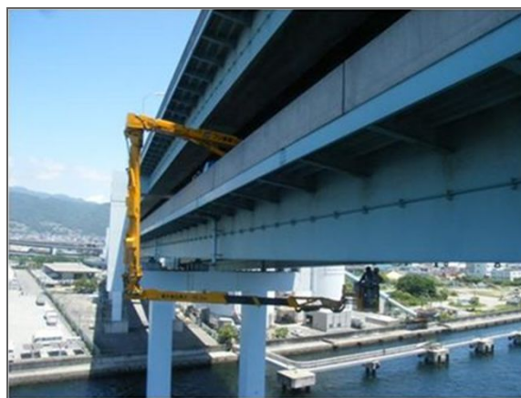
〔橋梁点検車による近接点検〕
