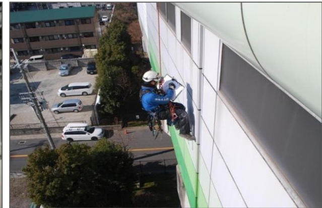
〔ロープアクセスによる料金所周辺の点検〕
