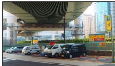
〔駐車場事業(堂島川駐車場)〕
