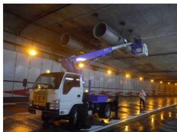
【トンネル換気設備 定期点検】
