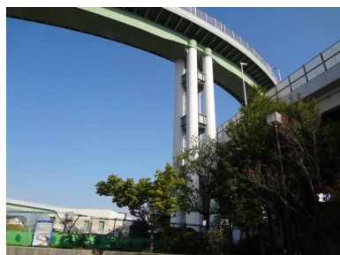
【淀川左岸線 海老江JCT】 (鋼管集成橋脚)
