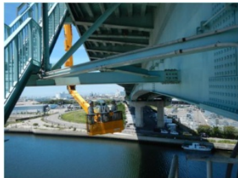
【橋梁 定期点検】
