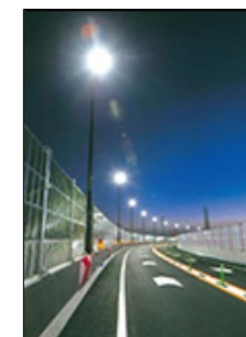
【京都線(斜久世橋区間)】 (LED照明の採用)
