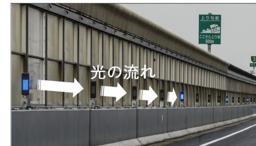
(深江付近に設置した速度回復誘導灯)
