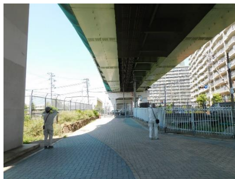
日常点検（路下）
