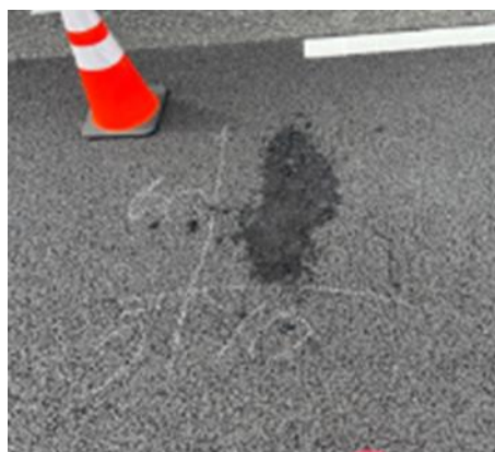
ポットホールの緊急対応の様子
