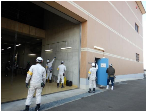
建物の点検実施状況
