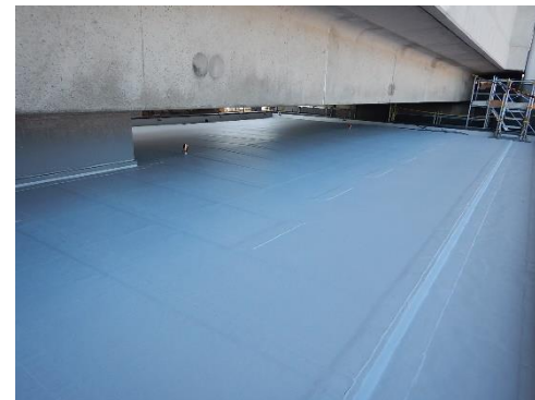
菱江施設基地事務所屋上防水 （補修後）
