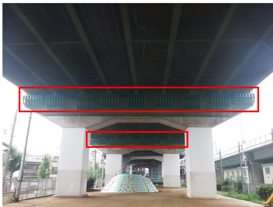
上部工の耐震補強
