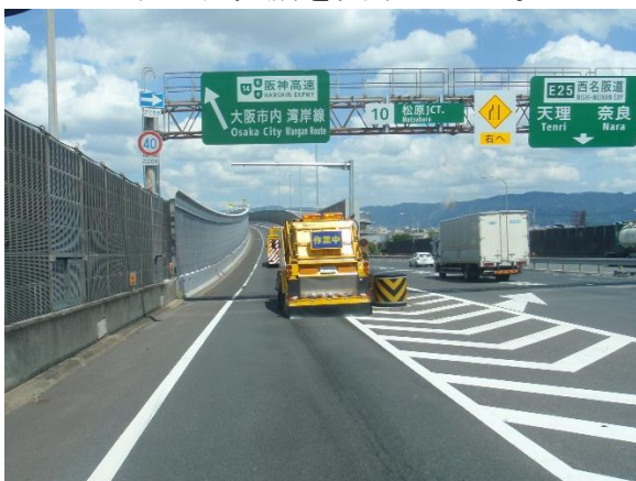
路面清掃状況
