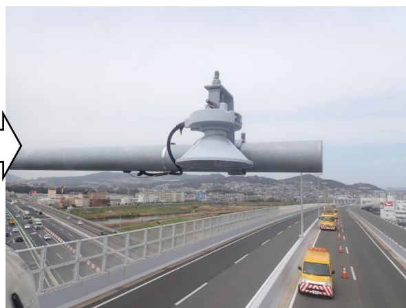
車両検知ヘッド補修後
