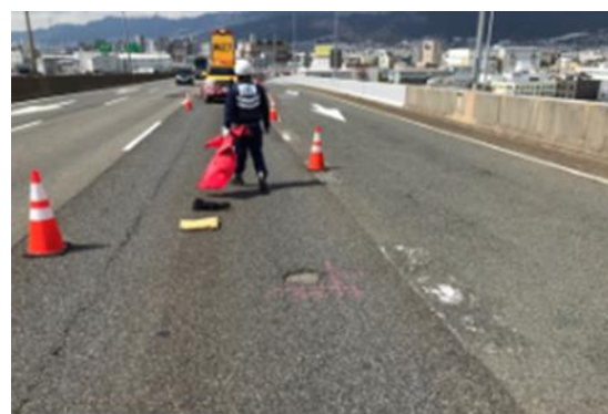
ポットホールの緊急対応の様子
