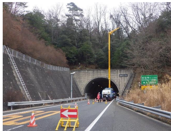
雑木伐採作業状況
