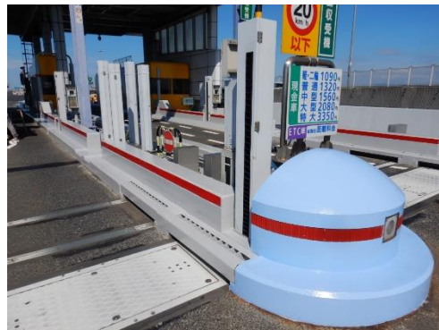
料金所アイランド損傷（補修後）
