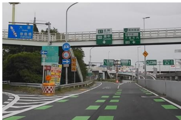
高速入口でのカラー舗装による誤進入対策
