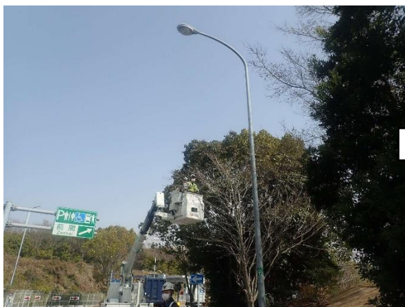
前開 PA 道路照明の取り替え前
