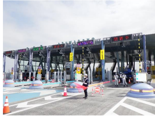
料金所の点検実施状況
