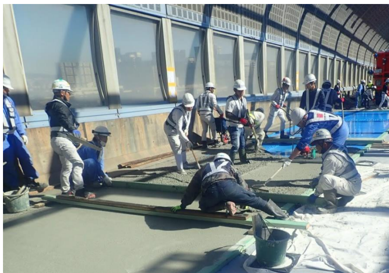
SFRC 舗装施工状況
