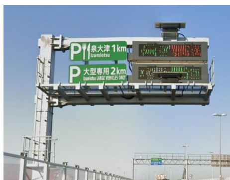
満車比較表示板 (泉大津PA（陸側）と泉大津大型専用PA)
