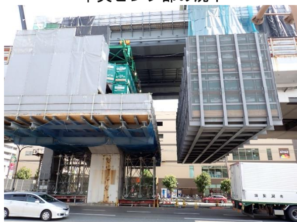
既設桁撤去状況
