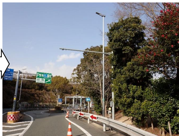
前開 PA 道路照明の取り替え後
