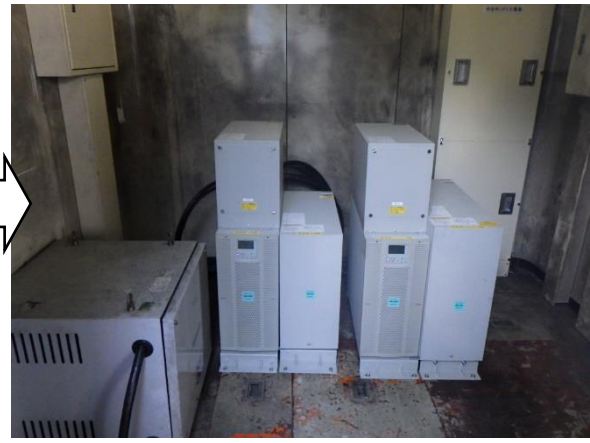
料金所無停電電源装置補修後
