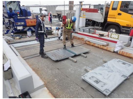
車両重量計設備定期点検
