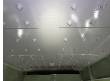
補修後（鋼板接着補強）
