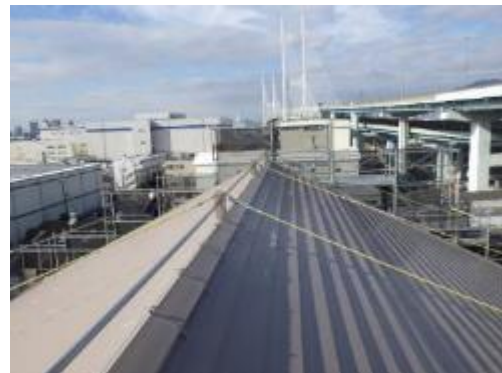
深江浜管理所屋上（補修後）
