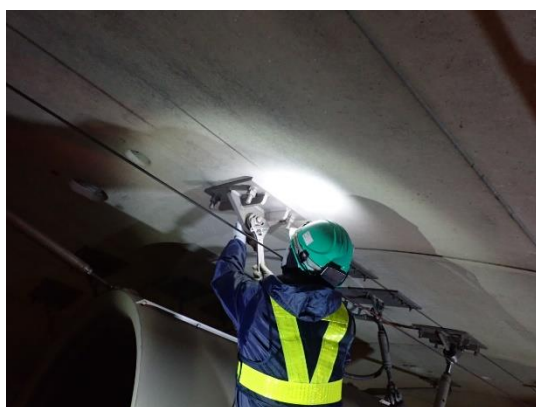
トンネル換気設備定期点検
