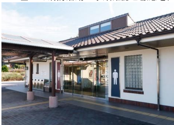
自動ドア、空調設備設置（白川PA）
