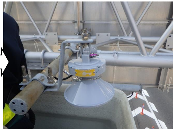
車両検知ヘッド補修後
