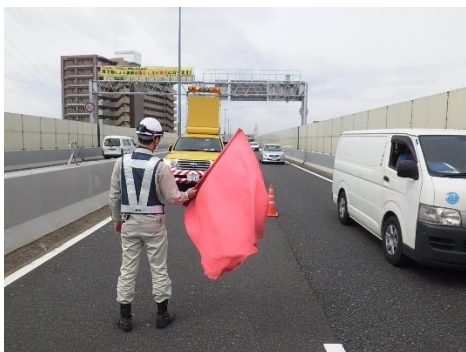
日常点検（路上）
