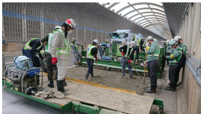
SFRC 舗装施工状況
