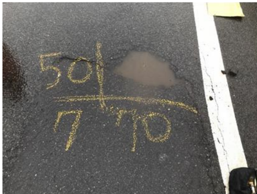
ポットホールの緊急対応の様子
