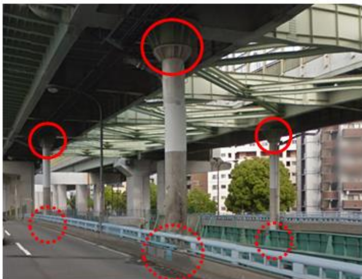
特殊橋脚の補強（ロッキング橋脚）
