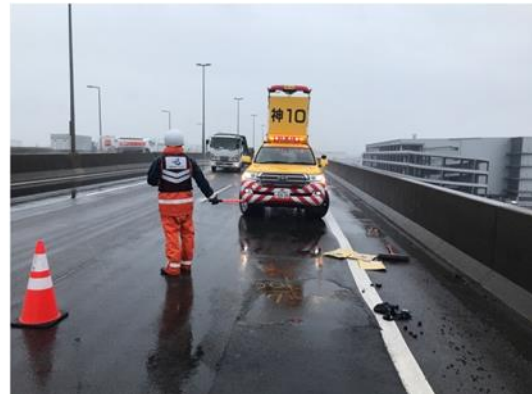
ポットホールの緊急対応の様子
