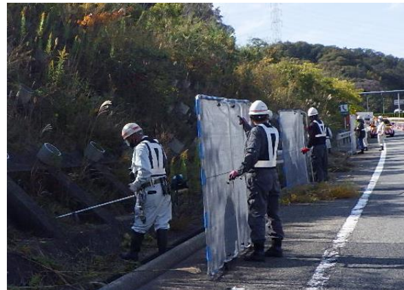
除草作業状況
