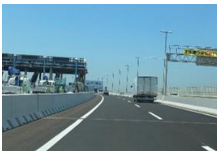
泉大津本線料金所 撤去後
