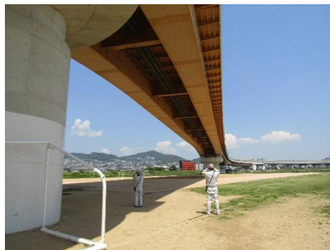
日常点検（路下）
