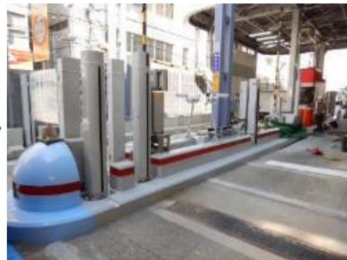
料金所アイランド損傷（補修後）
