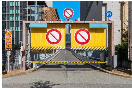
中之島入口への設置例
