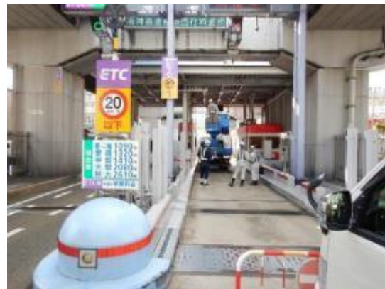
料金所の点検実施状況
