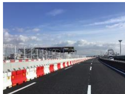
中島本線料金所 撤去後
