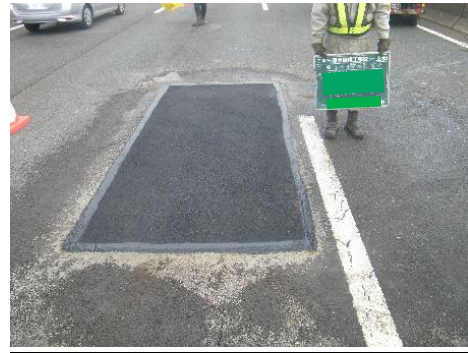
補修後（舗装の部分打替え）
