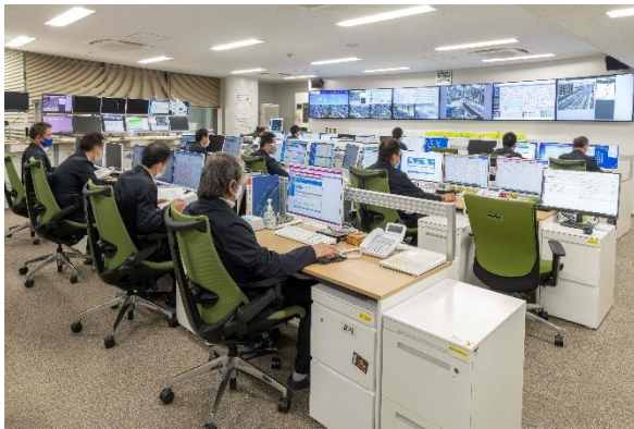
設備監視（大阪地区）
