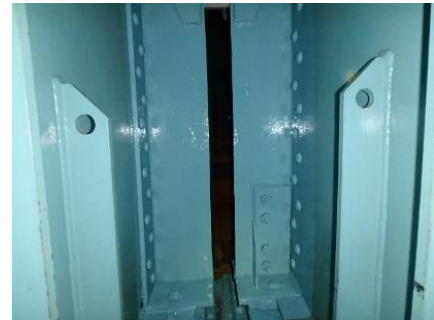
補修後（塗装塗替）
