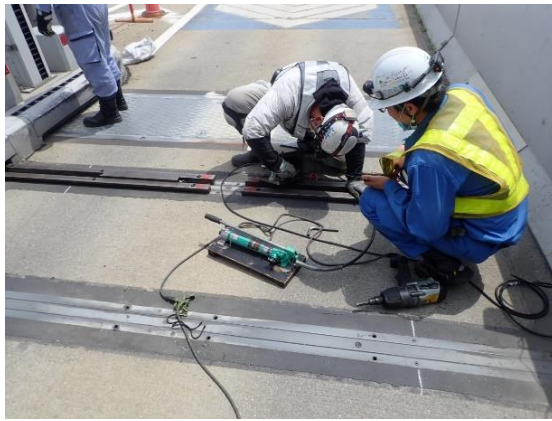
車両重量計設備定期点検
