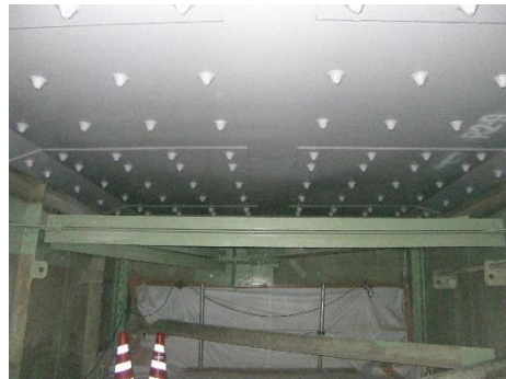
補修後（鋼板接着補強）
