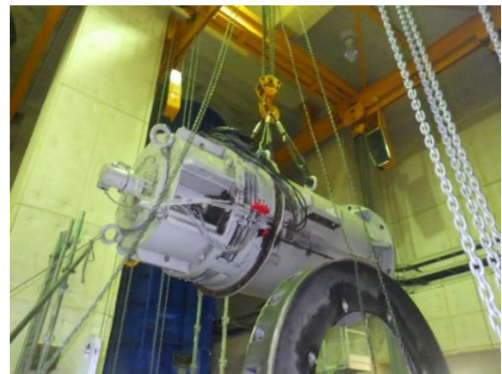
神戸長田トンネル南行 中央換気所排風機分解整備
