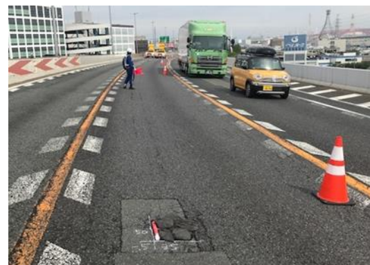
ポットホールの緊急対応の様子
