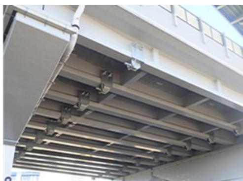
PC 桁外ケーブル補強状況
