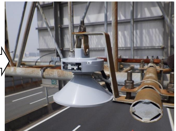
車両検知ヘッド補修後
