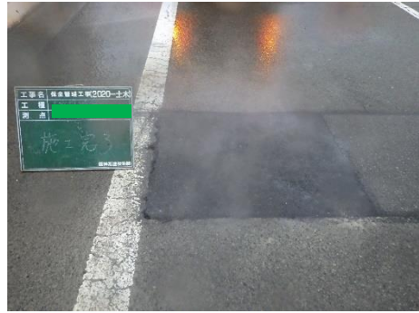
補修後（舗装の部分打替え）
