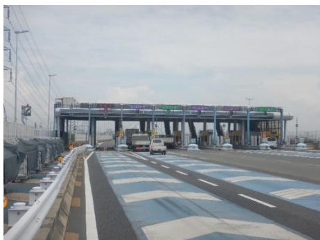
高石本線料金所
