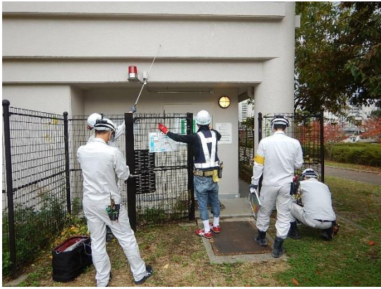
建物の点検実施状況
