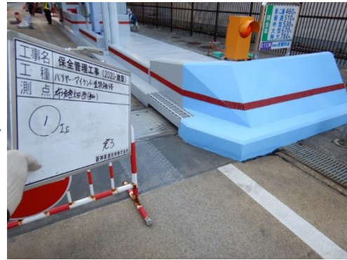
料金所アイランド損傷（補修後）
