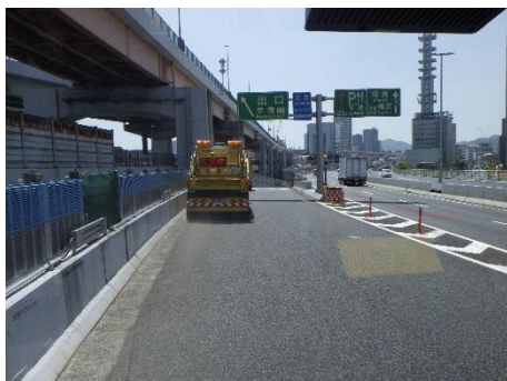
路面清掃状況
