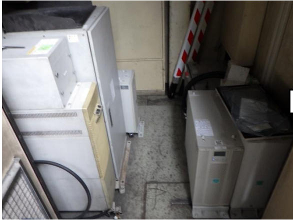
料金所無停電電源装置補修前
