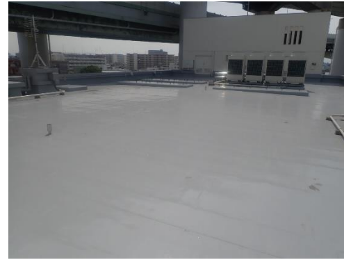
湾岸管理所第一社屋屋上（補修後）
