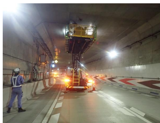
トンネル換気設備定期点検
