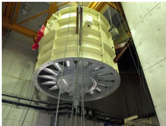
神戸長田トンネル南行 中央換気所排風機分解整備
