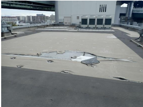
湾岸管理所第一社屋屋上（補修前）
