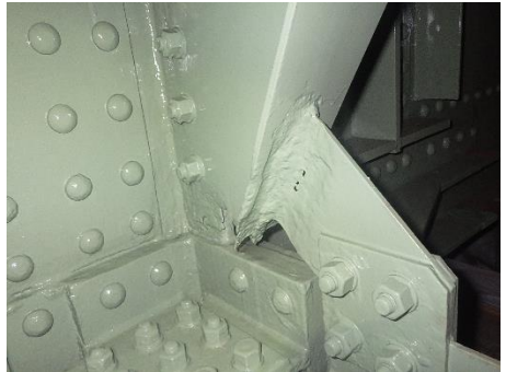
補修後（塗装塗替）
