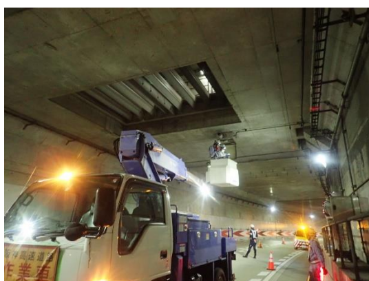
トンネル換気設備定期点検
