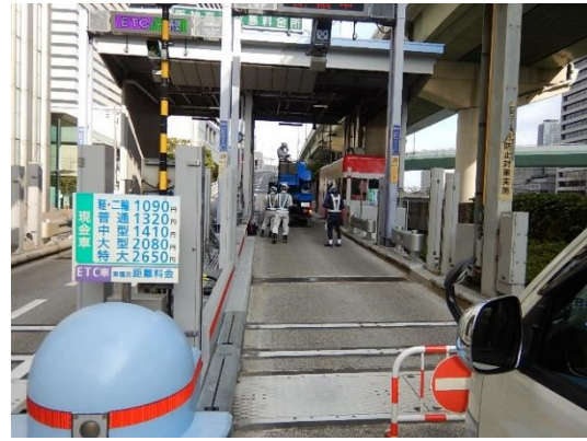
料金所の点検実施状況
