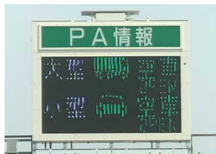
満車表示板の設置
