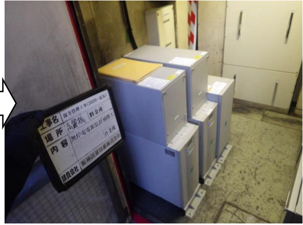
料金所無停電電源装置補修後
