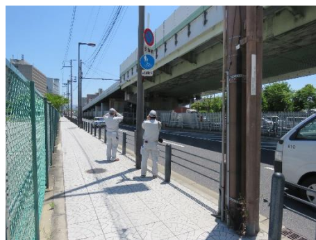
日常点検（路下）
