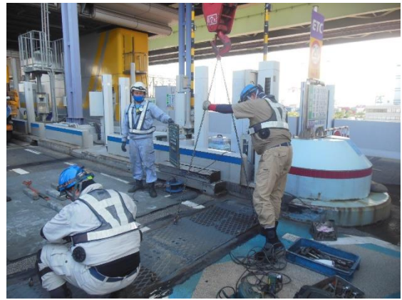
車両重量計設備定期点検
