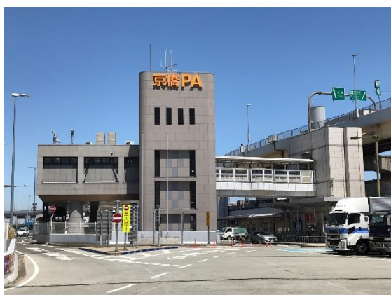
京橋PA ネオンサインの改修
