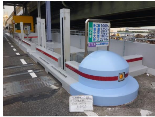
料金所アイランド損傷（補修後）
