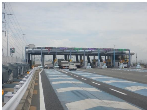
高石本線料金所撤去前
