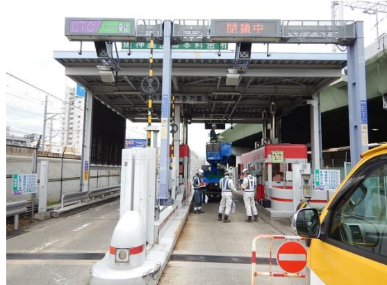
料金所の点検実施状況
