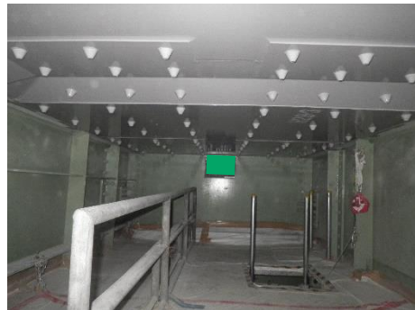
補修後（鋼板接着補強）
