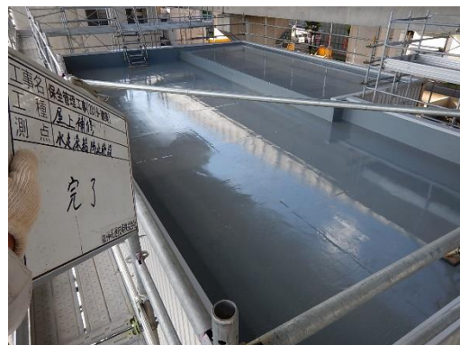
水走凍結防止施設屋上（改修後）
