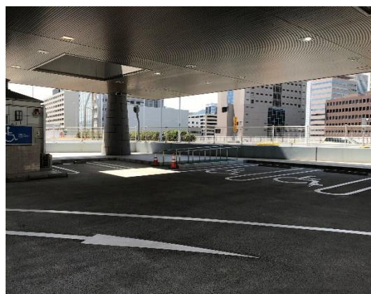
京橋PA 身障者駐車マス再配置
