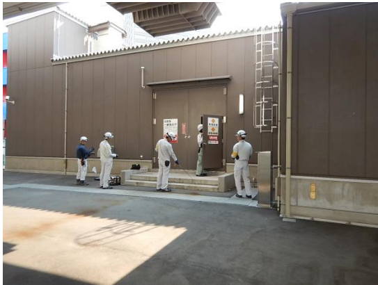
建物の点検実施状況
