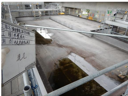
水走凍結防止施設屋上（改修前）
