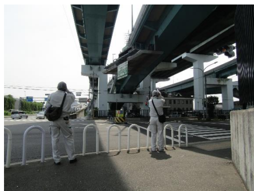
日常点検（路下）
