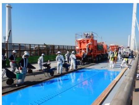
接着剤塗布状況
