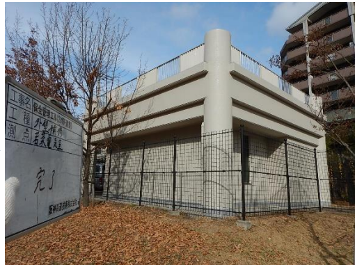
若菜電気室外壁（補修後）
