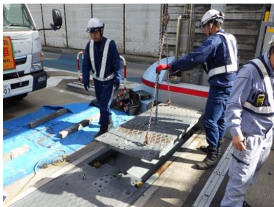
車両重量計設備定期点検
