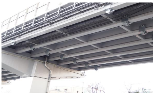
PC 桁外ケーブル補強状況
