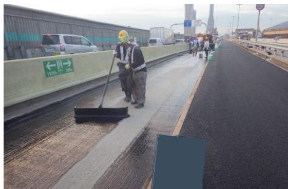
高性能床版防水施工状況
