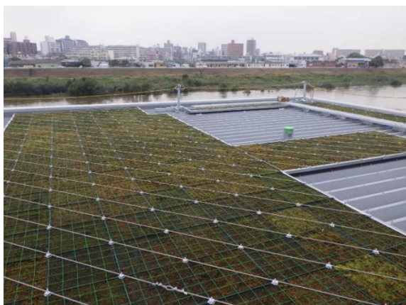
常盤東料金所 屋上緑化
