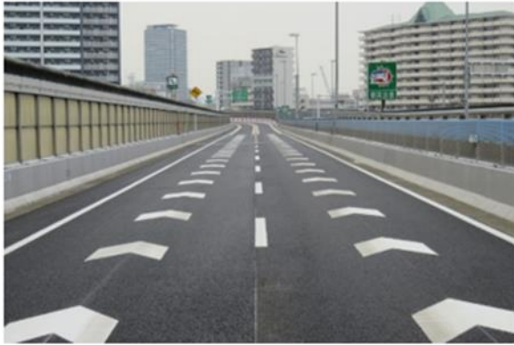
カーブ区間手前での速度抑制対策
