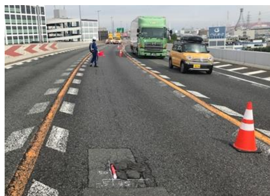
ポットホールの緊急対応の様子
