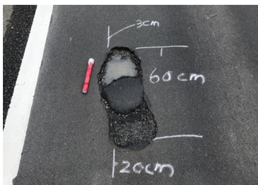
ポットホールの緊急対応の様子
