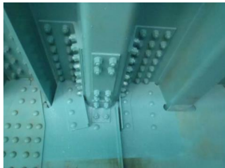
補修後（当て板補強）
