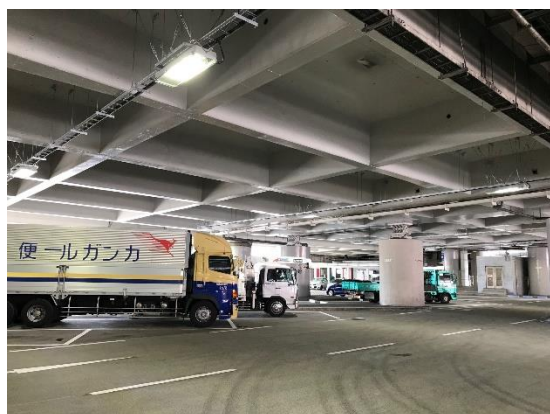
京橋PA 駐車場照明のLED化
