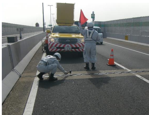
日常点検（路上）
