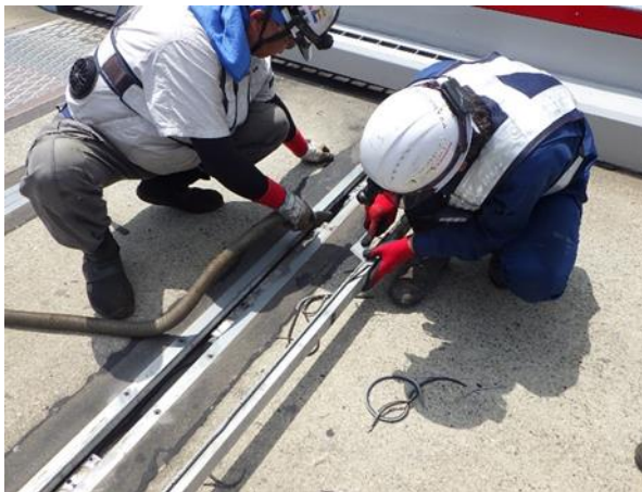
棒状センサー交換補修
