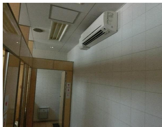
京橋PA トイレの空調化
