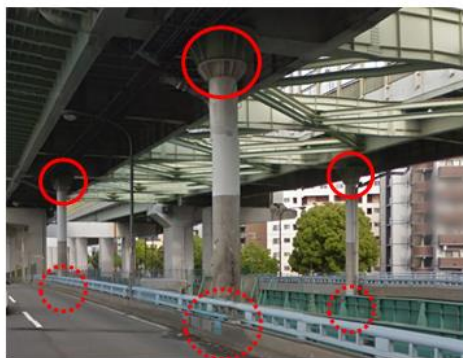
特殊橋脚の補強（ロッキング橋脚）
