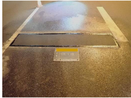
補修後（舗装の部分打替え）
