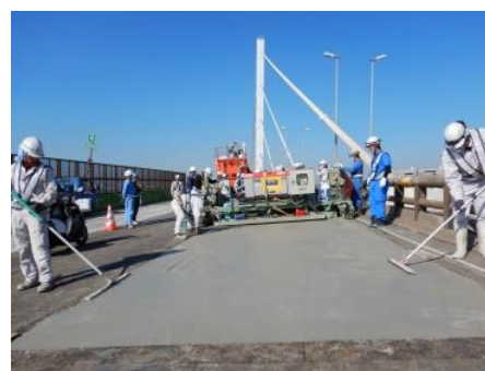
SFRC 敷設状況
