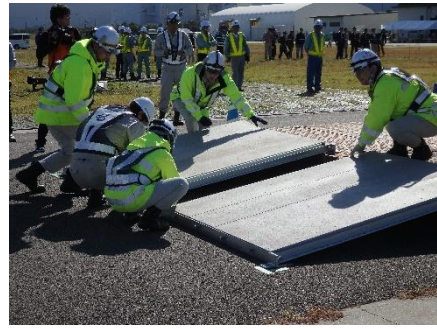
道路啓開訓練（段差補修）
