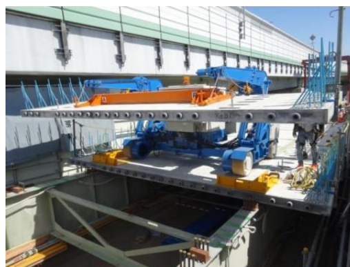
UFC床版設置状況
