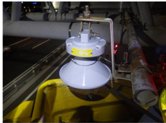
車両検知ヘッド補修後
