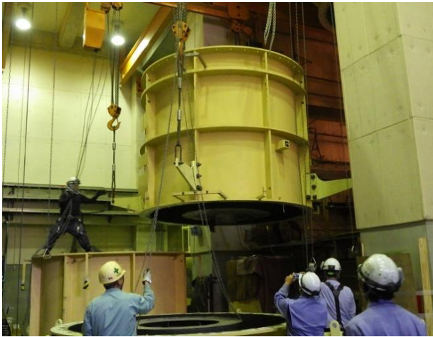
蓮宮換気所南行き 2号排風機分解整備（ケーシング分解、組立て用足場設置中）
