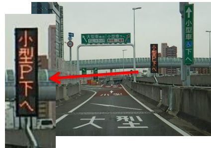
LED誘導表示板設置（泉大津P A）
