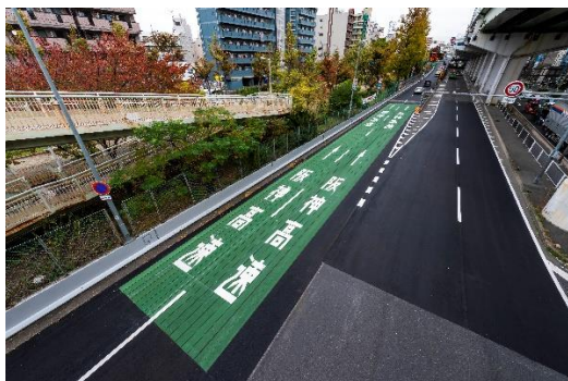
15号堺線 堺（安井町）入口
