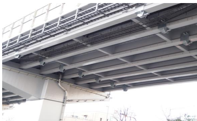
PC 桁外ケーブル補強状況
