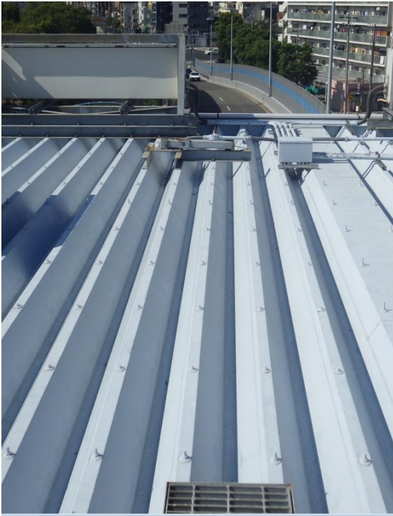
生田川料金所 屋上緑化前
