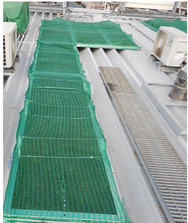
生田川料金所 屋上緑化後（養生中）
