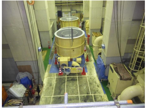
蓮宮換気所南行 1号排風機分解整備（分解用足場設置、ケーシング取外し）
