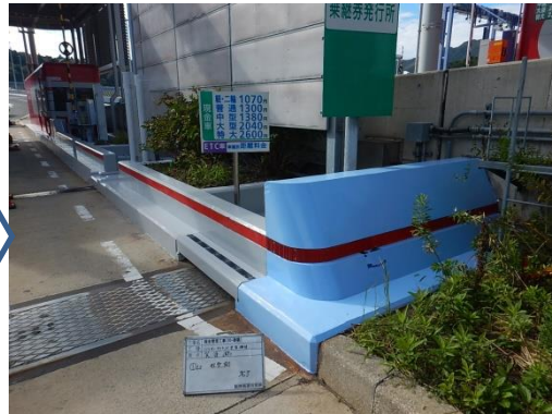
料金所アイランド損傷（補修後）
