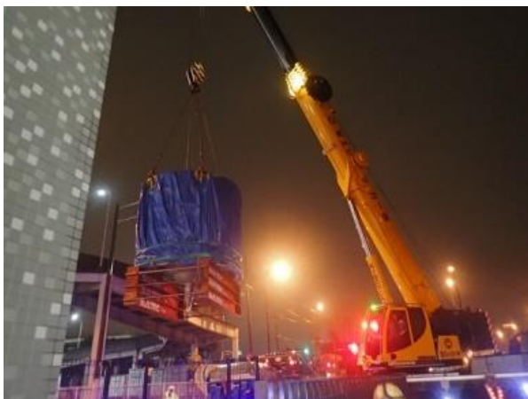
島屋換気所 2号排風機分解整備（排風機搬入、排風機取付け）
