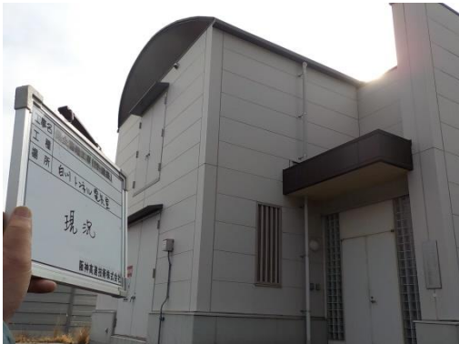
白川トンネル電気室外壁（補修前）
