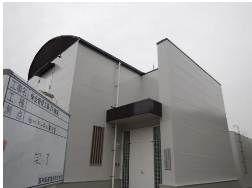
白川トンネル電気室外壁（補修後）
