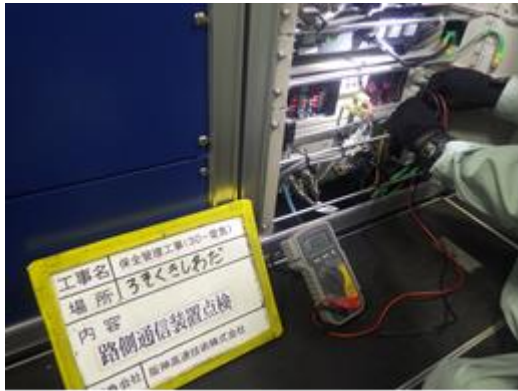
路側ラジオ点検
