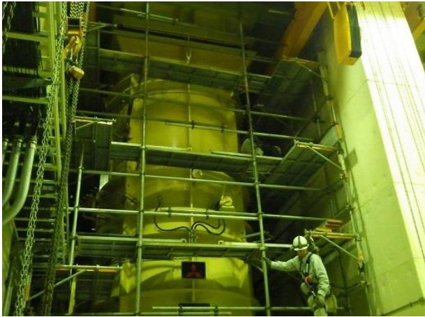
蓮宮換気所南行 1号排風機分解整備（分解用足場設置、ケーシング取外し）
