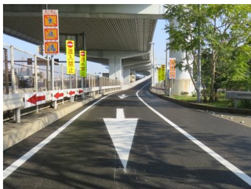
3号神戸線 尼崎東出口
