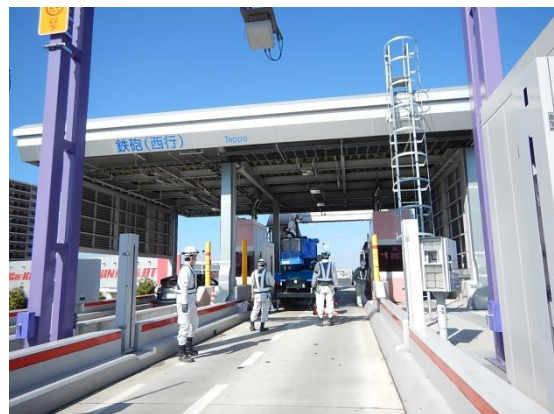
料金所の点検実施状況
