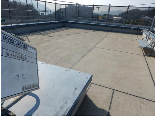
白川トンネル主水槽（改修前）
