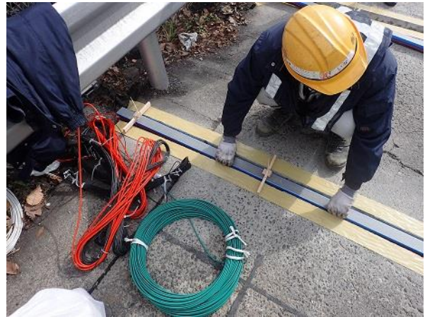
棒状センサー交換補修
