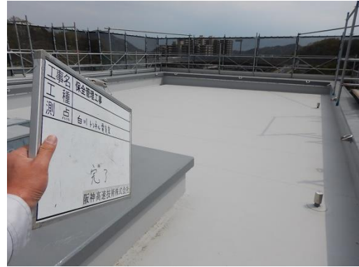
白川トンネル主水槽（改修後）
