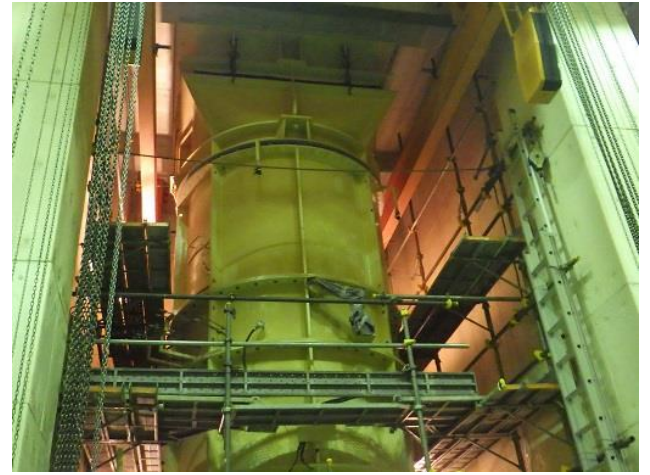
蓮宮換気所南行き 2号排風機分解整備（ケーシング分解、組立て用足場設置中）
