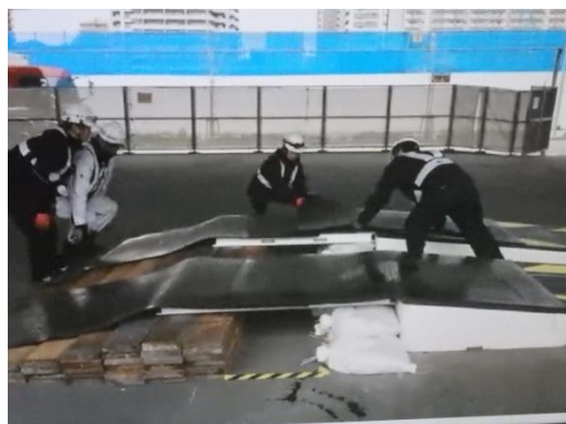
路面段差補修状況
