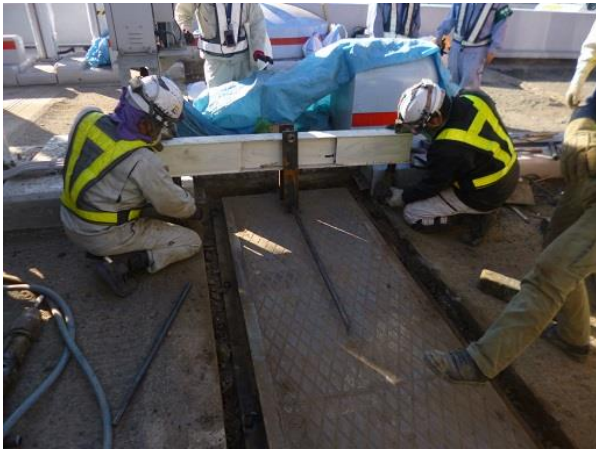
検出部交換補修
