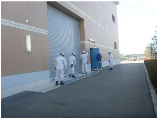
建物の点検実施状況
