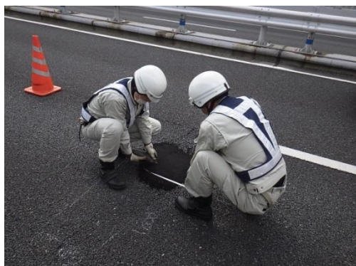
日常点検（路上）
