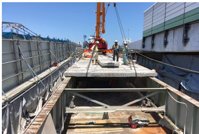
RC 床版取替え状況
