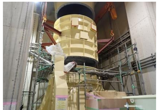
島屋換気所 2号排風機分解整備（排風機搬入、排風機取付け）
