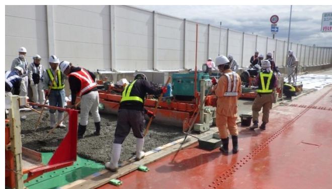
SFRC 敷設状況
