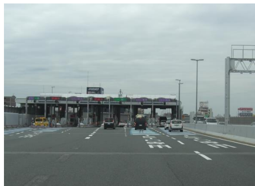
ETCレーン追加による安全対策 (13号東大阪線・長田集約料金所)
