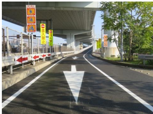
3号神戸線 尼崎東出口
