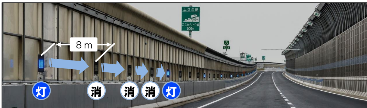
3号神戸線 upper 深江サグ部に設置された速度回復誘導灯
