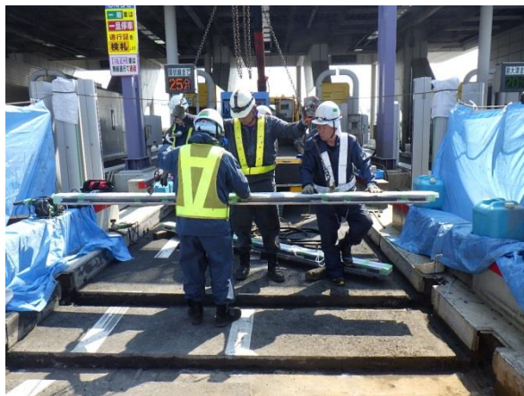
棒状センサー交換補修
