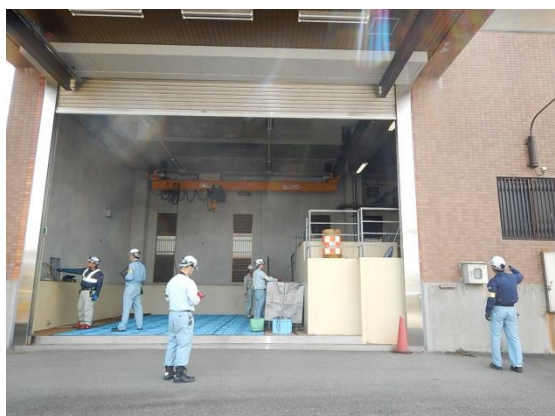
建物の点検実施状況
