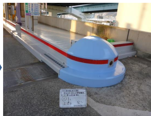
料金所アイランド損傷（補修後）
