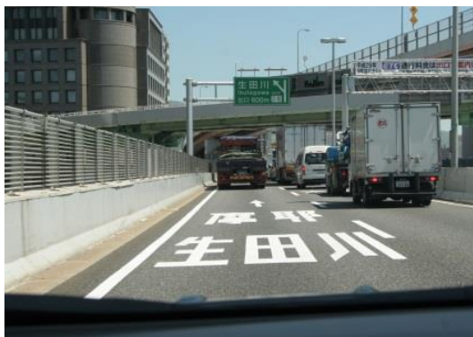
路面表示による注意喚起 (3号神戸線摩耶・生田川出口案内)
