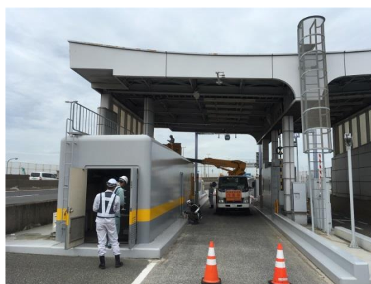
料金所の点検実施状況
