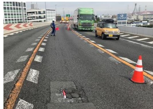
ポットホールの緊急対応の様子
