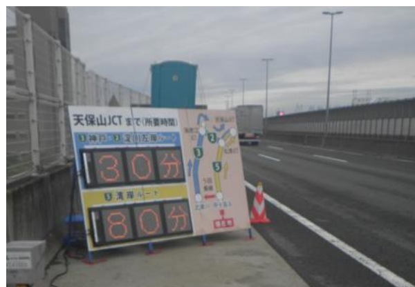
工事区間とう回ルートの所要時間の掲示
