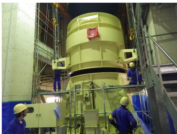
妙法寺換気所 2号排風機分解整備（ケーシング分解、電動機取り外し）
