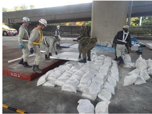
路面段差補修状況
