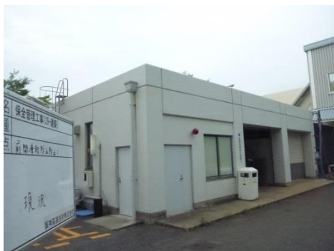
前開凍結防止基地外壁（改修前）
