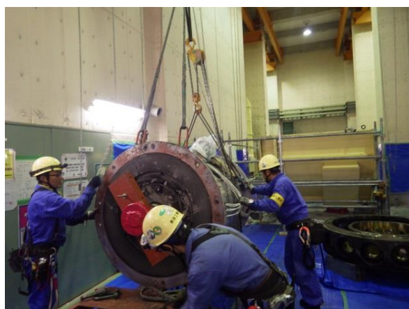
妙法寺換気所 2号排風機分解整備（ケーシング分解、電動機取り外し）
