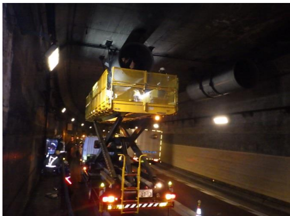
ジェットファン取り外し中
