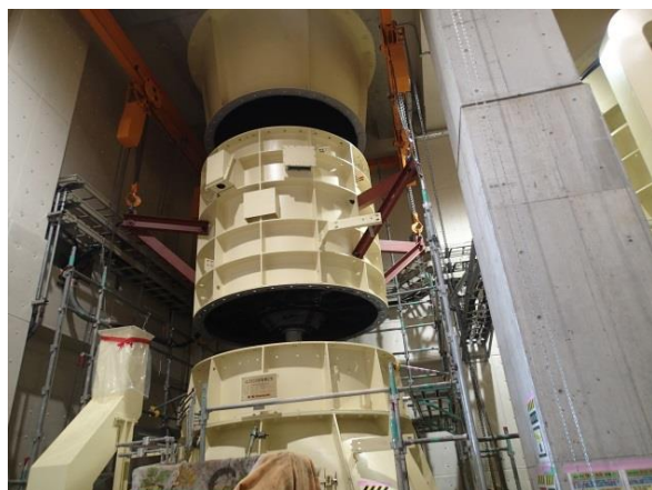
島屋換気所 1号排風機分解整備（ケーシング分解、電動機工場検査）
