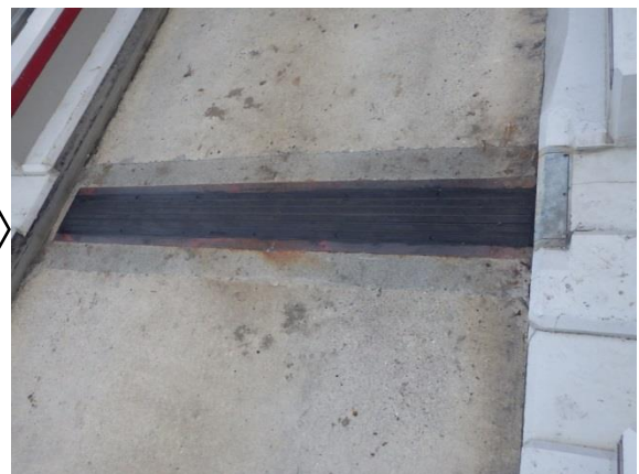
軸数検知器補修後
