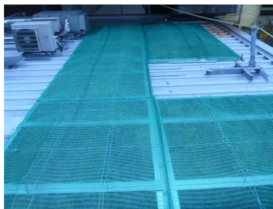
屋上緑化後 (養生中)
