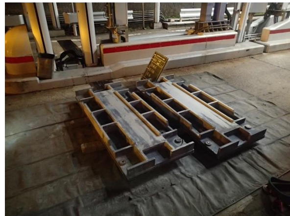
軸重計測設備定期点検
