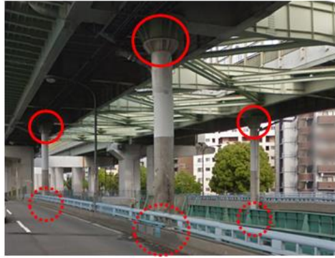
特殊橋脚の補強（ロッキングピア）
