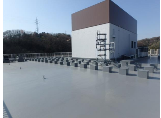
藍那管理基地（改修後）
