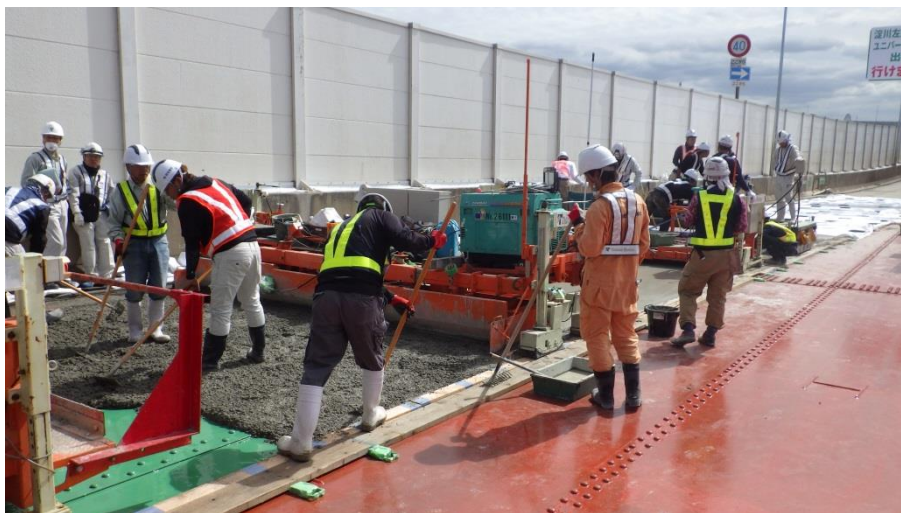
SFRC 敷設状況（5号湾岸線リニューアル工事）
