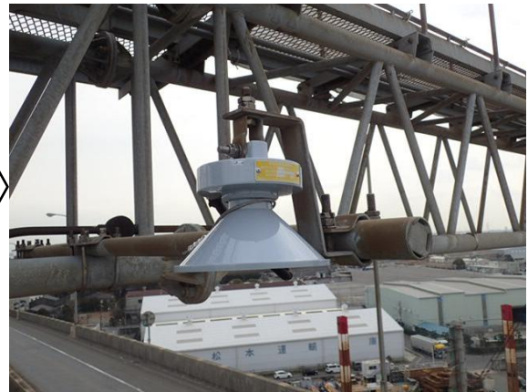
車両検知ヘッド補修後
