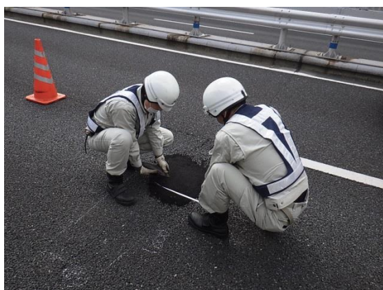
日常点検（路上）
