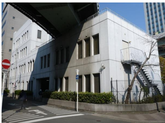
信濃橋管理基地（改修前）
