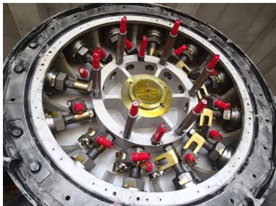
大開換気所1号排風機分解整備（動翼可変機構分解、駆動軸確認）
