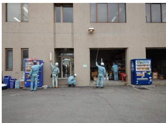
建物の点検実施状況
