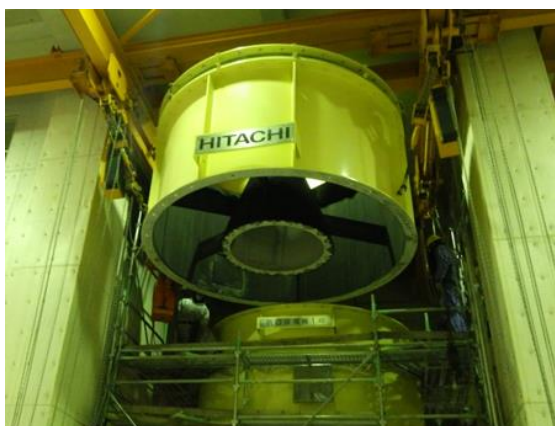
妙法寺換気所坑口1号排風機分解整備（ケーシング分解、翼車分解）
