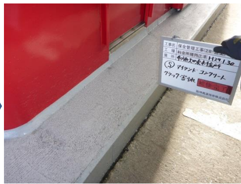
料金所アイランド損傷（補修後）
