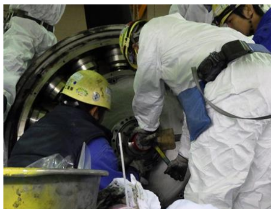
妙法寺換気所坑口1号排風機分解整備（ケーシング分解、翼車分解）
