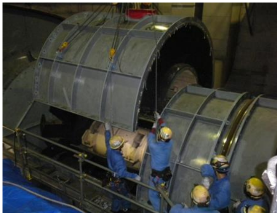
南換気所2号排風機分解整備（ケーシング分解、電動機・翼車取付完了）
