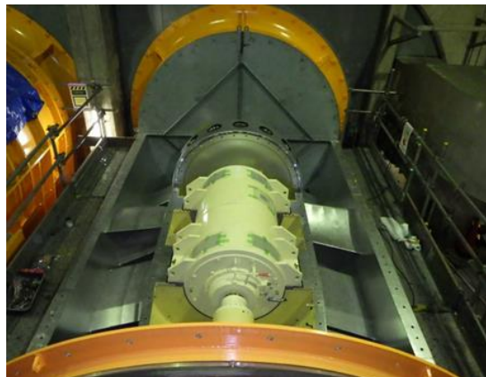
南換気所2号排風機分解整備（ケーシング分解、電動機・翼車取付完了）
