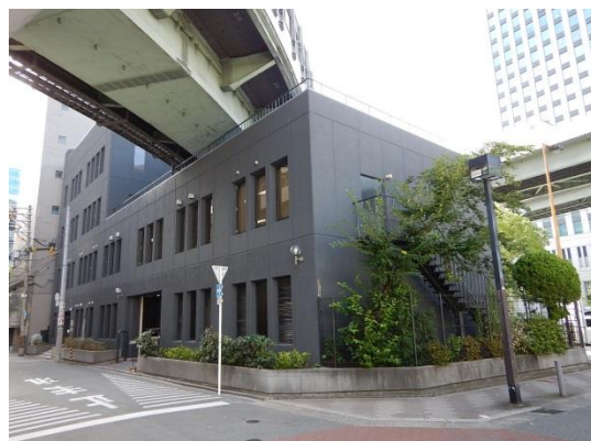
信濃橋管理基地（改修後）
