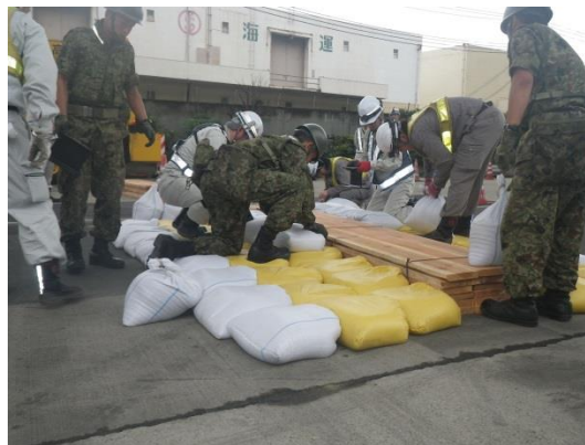
路面段差補修状況
