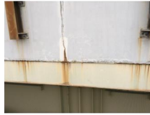
鋼製高欄部の損傷 (漏水による腐食)
