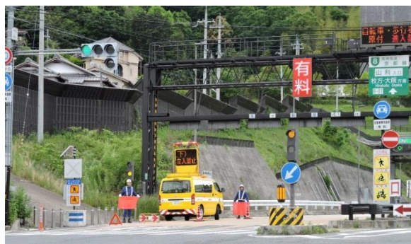
逆走・誤進入防止立哨
