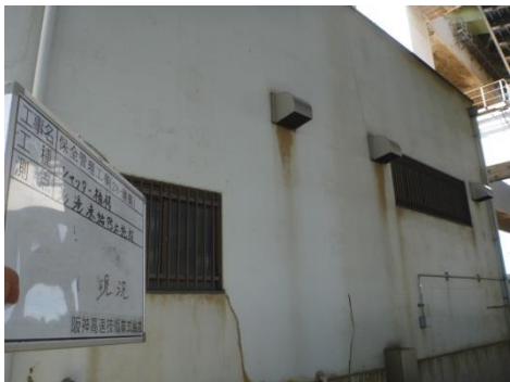
北港凍結防止基地外壁（改修前）
