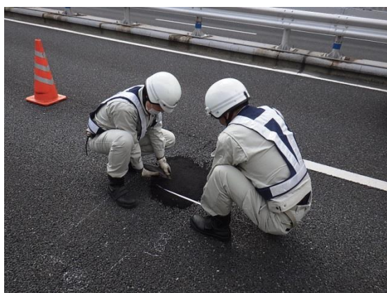
日常点検（路上）
