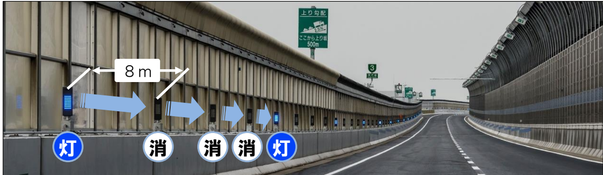
3号神戸線上り深江サグ部に設置された速度回復誘導灯
