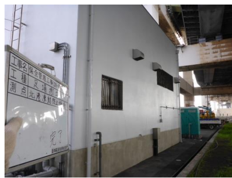
北港凍結防止基地外壁（改修後）
