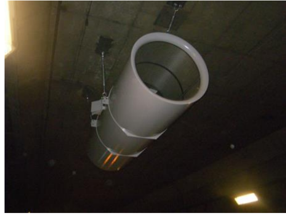
代替機取り付け完了
