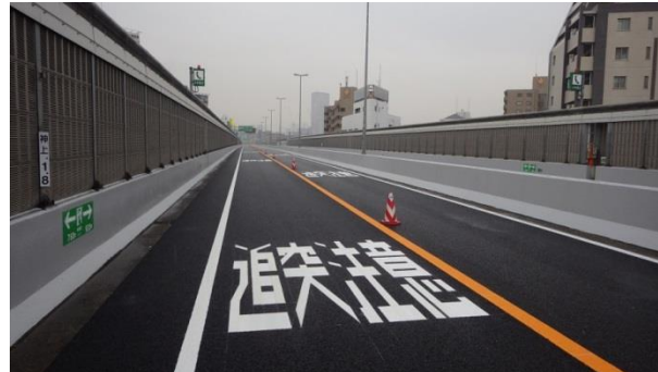
3号神戸線 野田カーブ手前部
