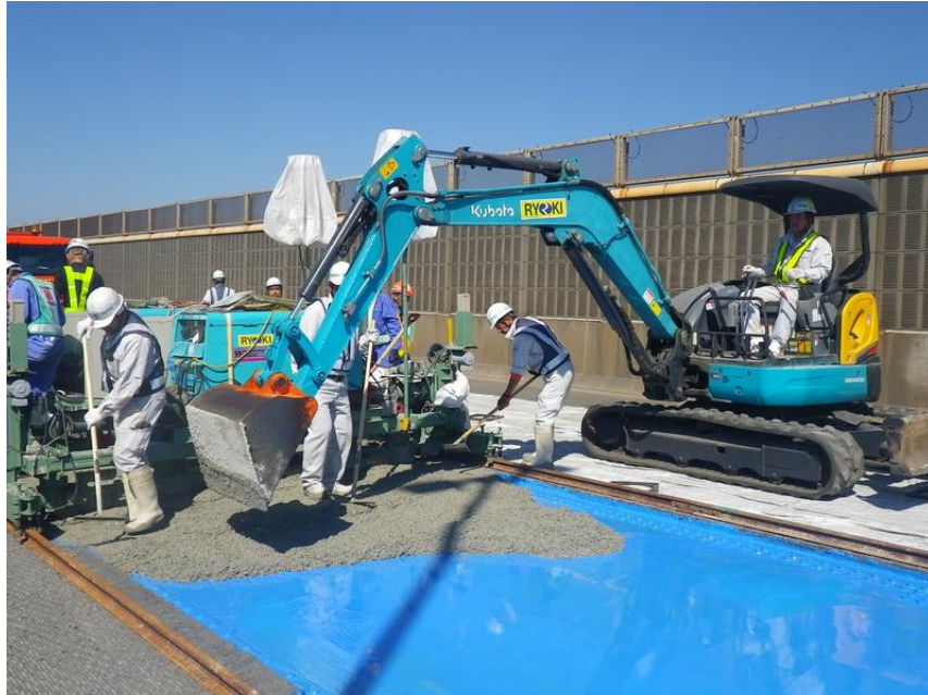
SFRC 敷設状況（5号湾岸線フレッシュアップ工事）
