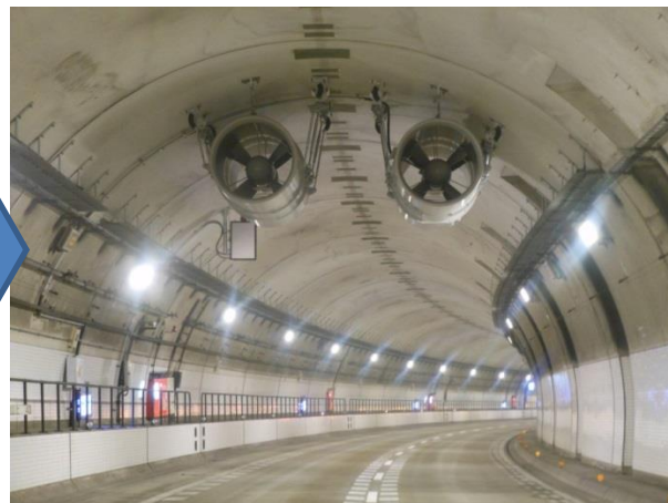
31号神戸長田トンネル天井板 （撤去後）
