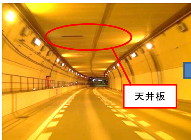
31号神戸長田トンネル天井板 （撤去前）
