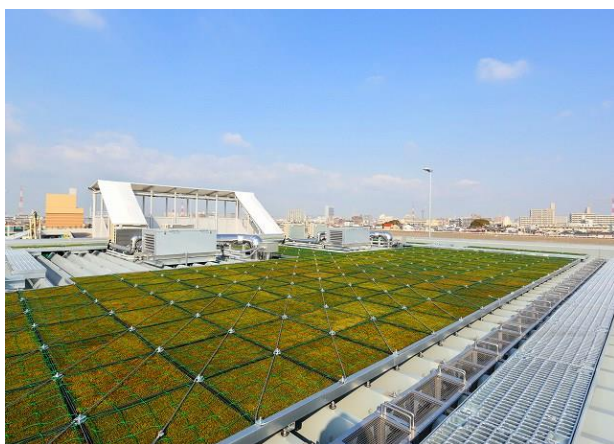
料金所屋根緑化状況
