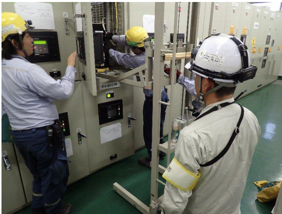
受変電設備点検
