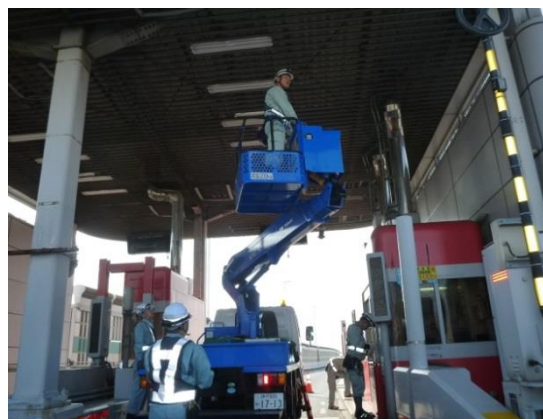
料金所の点検実施状況
