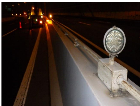
一位式点滅灯補修前
