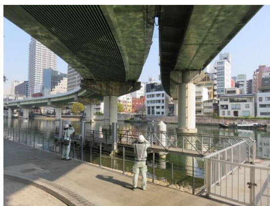
日常点検（路下）
