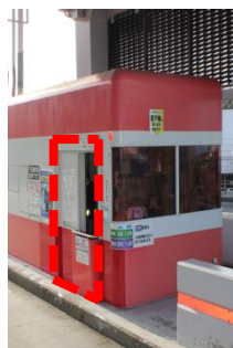
料金自動収受機設置前
