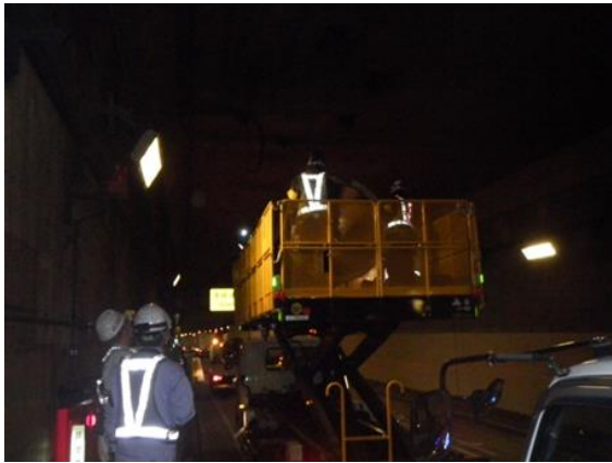
ジェットファン取り外し中
