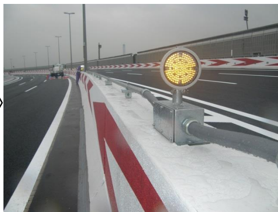
一位式点滅灯補修後
