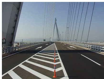
5号湾岸線 (南港～北港 JCT)
