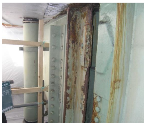
環状線 鋼桁端部さび・腐食（補修前） 環状線 鋼桁端部さび・腐食（補修後）
