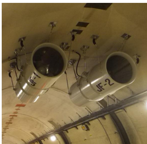
神戸長田トンネル（ジェットファン増設）
