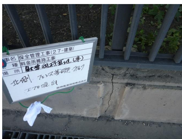
建物外構の点検実施状況
