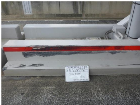
料金所アイランド車両接触（補修前）
