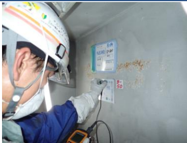
〔測定状況(超音波板厚計)〕
