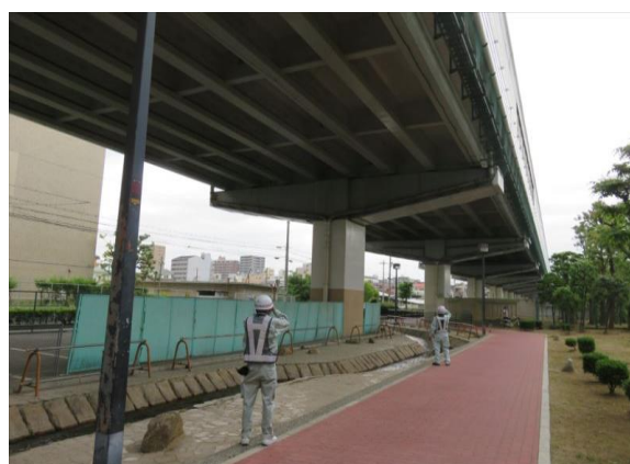
日常点検（路下）
