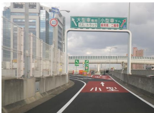
小型車駐車階分岐路のカラー舗装 (泉大津PA)
