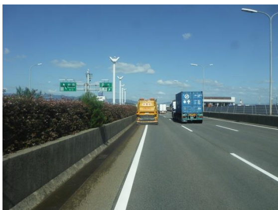
路面清掃作業
