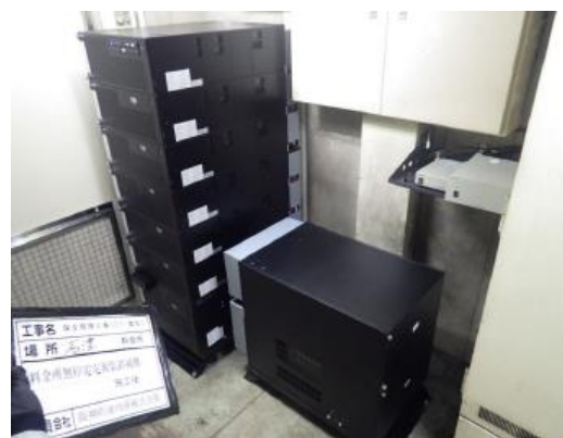
無停電電源装置取替後
