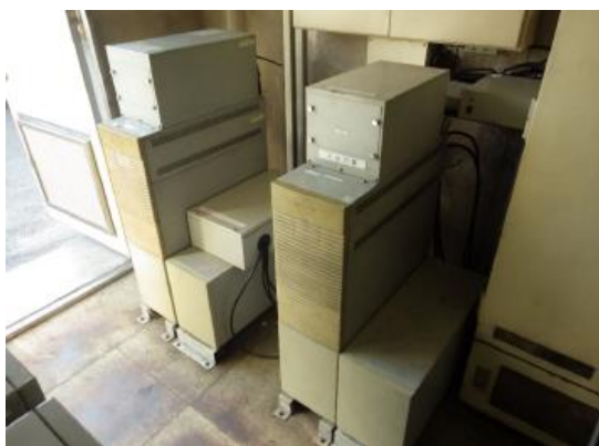
無停電電源装置取替前
