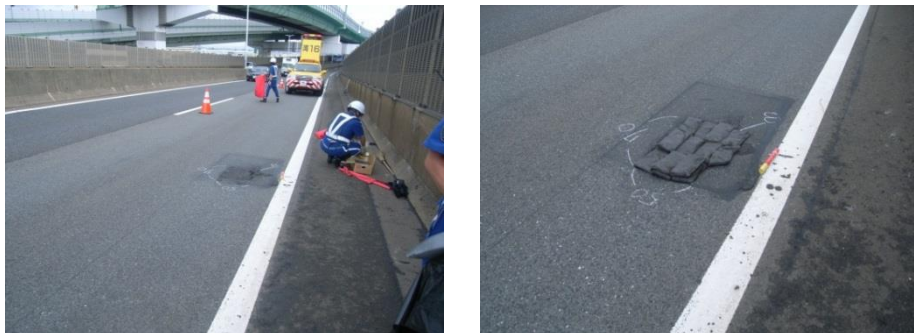
ポットホールの緊急対応の様子
