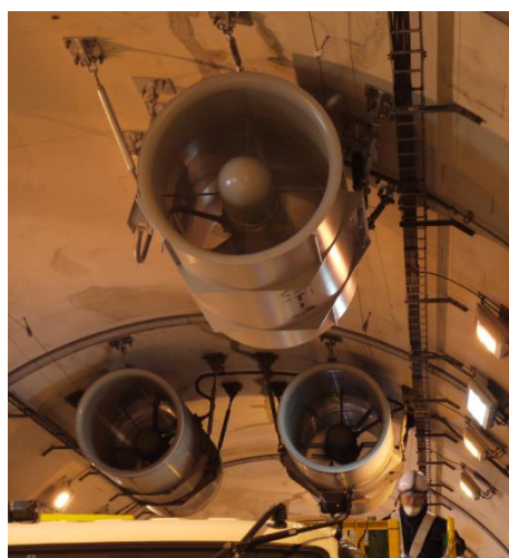
有馬北トンネル（奥側：旧 手前：新）
