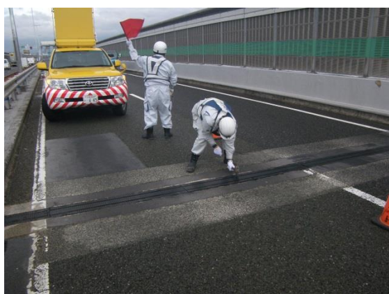
日常点検（路上）
