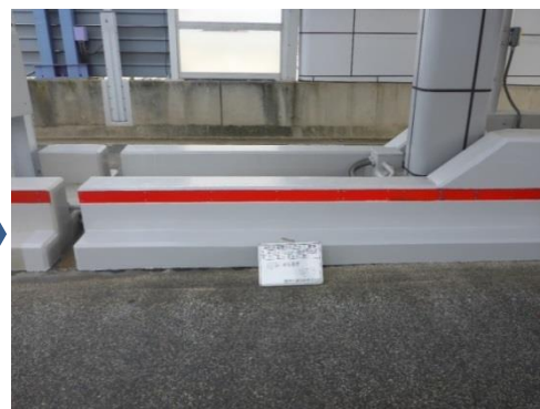
料金所アイランド車両接触（補修後）
