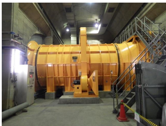
排風機オーバーホール完了
