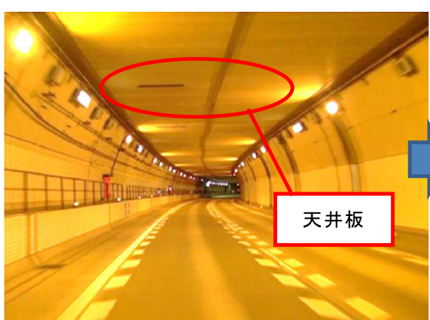
31号神戸長田トンネル天井板 （撤去前）
