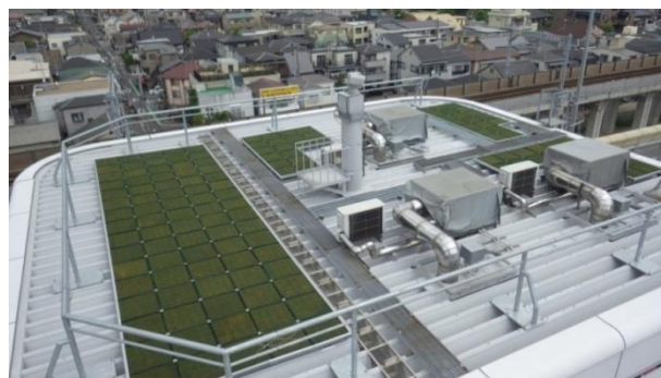
料金所屋根緑化状況 (芦屋入口料金所)
