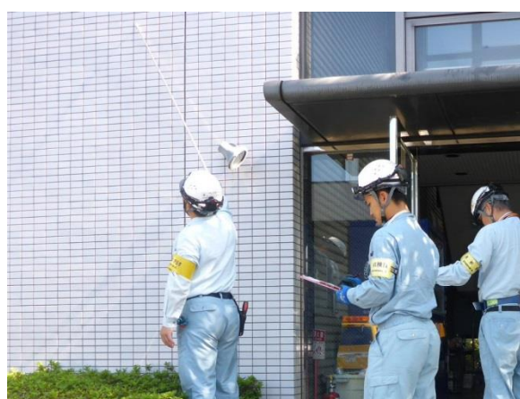
建物外壁の点検実施状況
