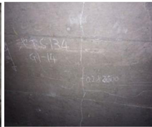
コンクリート桁の損傷 (ひび割れ)
