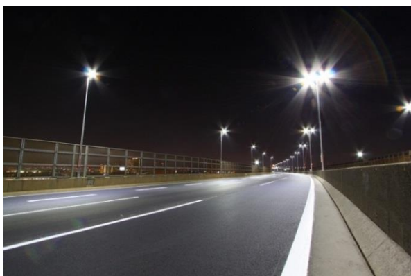
明かり部道路照明 (LED)
