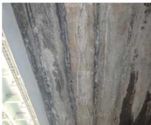
コンクリート桁の損傷 (ひび割れ)
