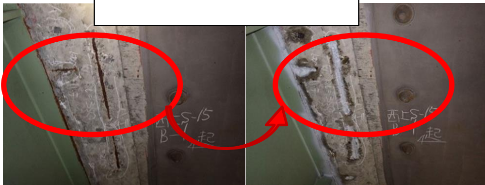
点検時応急措置（露出鉄筋防錆処置）
