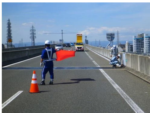
構造物日常点検時の支援（交通規制）
