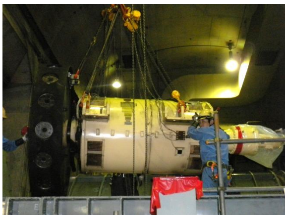
排風機分解整備中（翼車・電動機取外し中）
