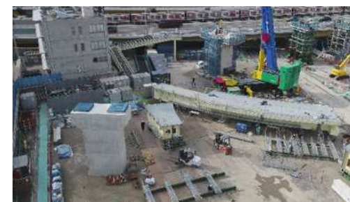
橋脚工事の実施状況
