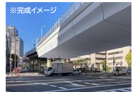
膜材による橋桁美装化（難波交差点）
