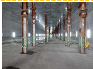
函体工事の実施状況
