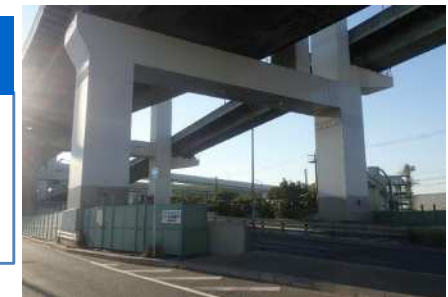
橋脚塗装による美装化（北港JCT付近）
