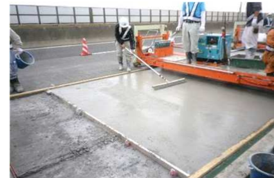
SFRC施工状況
