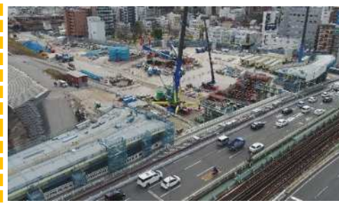
桁架設工事の実施状況
