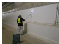
【老朽化した覆工コンクリートの補修】
