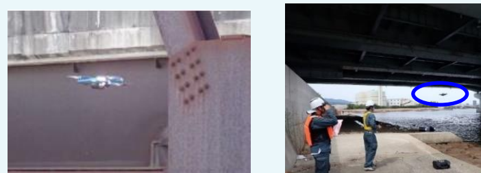
山間部・海上部におけるUAV点検の試行
