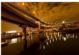
海上部の鋼床版 (湾岸線)
