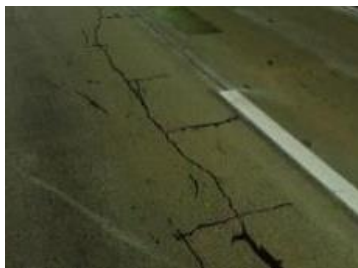
路面のひび割れ
