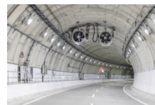
【トンネル内照明・換気設備の更新】
