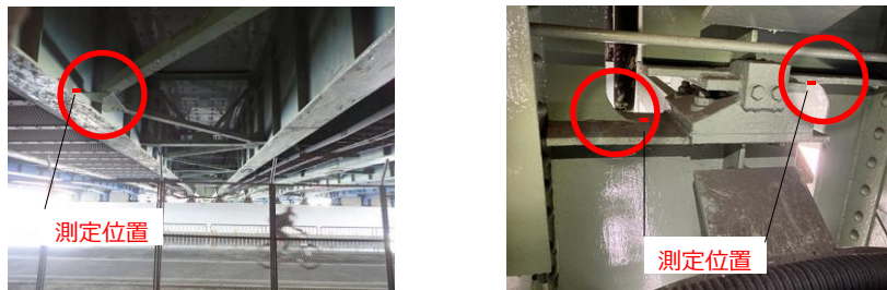
測定位置 (左：ガセット、右：ゲルバーヒンジ)
