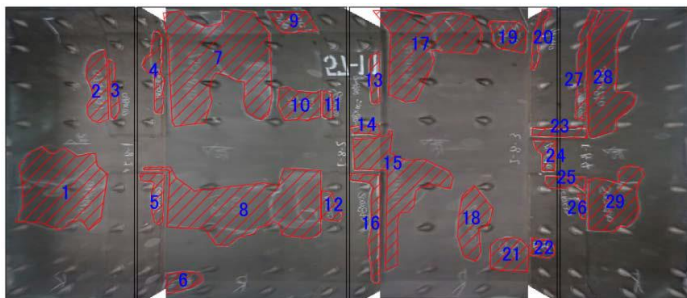
補強鋼板のたたき調査結果
