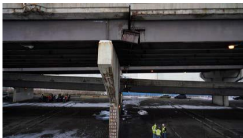
ゲルバーヒンジ部の破断事例 (アメリカ)
