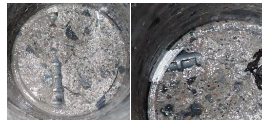
かさ上げコンクリート内部の鉄筋の状況
