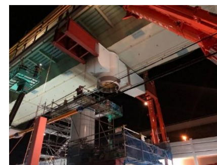
橋脚梁部の施工 (2022年8月撮影)
