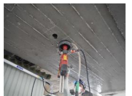
コア削孔調査（2021年10月撮影）
