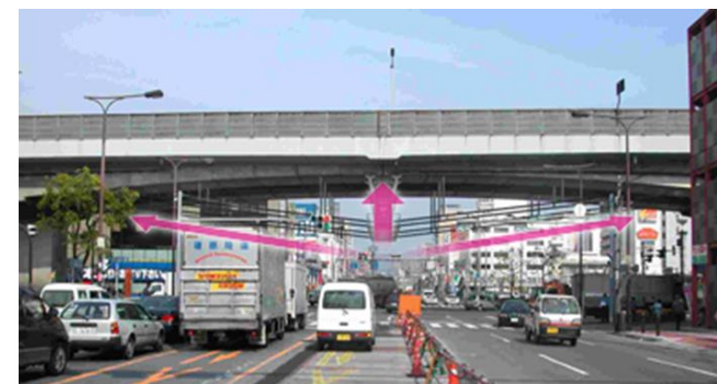
応急対策 (ケーブルで左右から引き上げ)
