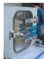
点検孔扉の取替
