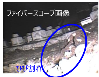
支承部の発錆・沓座コンクリートの破損 (15号堺線)
