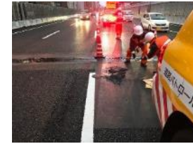
交通管理隊による 応急補修
