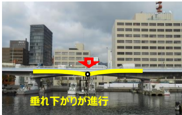
路面（ヒンジ部）の沈下
