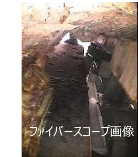
沓座コンクリートの破損・桁端部の発錆 (16号西大阪線)
