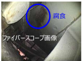
支承部の滞水、箱桁表面の発錆 (13号東大阪線)
