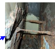
投棄防止柵支柱のアンカー部の減肉 (16号大阪港線 阿波座付近)
