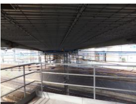
恒久足場等の設置
