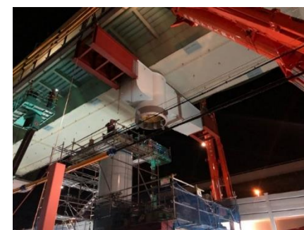
橋脚梁部の施工 (2022年8月撮影)
