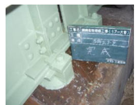
腐食・断面欠損部への 鋼板補強・ボルト取替
