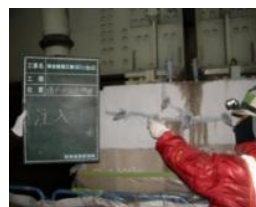
ひび割れ注入(断面修復)
