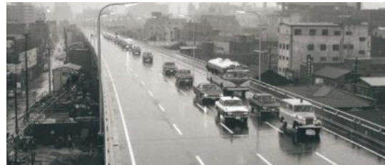
1号環状線 四ツ橋付近
