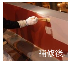
外面の腐食に対して、塗装塗替を実施
