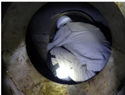
狭隘で点検困難な鋼製フーチング内の空間
