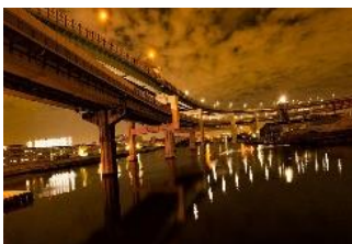
海上部の鋼床版 (湾岸線)
