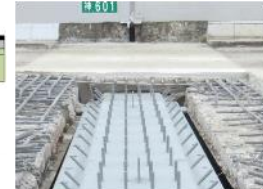
橋の継ぎ目による段差の解消 (漏水による腐食対策、重防食塗装も実施)
