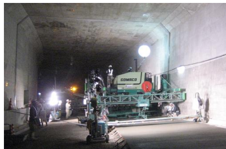
【例】連続鉄筋コンクリート舗装
