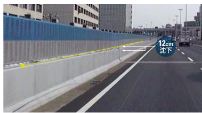
路面（ヒンジ部）の沈下
