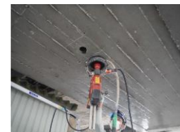
コア削孔調査（2021年10月撮影）
