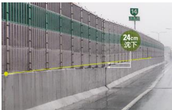
路面（ヒンジ部）の沈下
