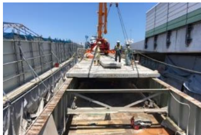
15号堺線 玉出ランプ 既設床版の撤去
