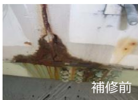
外面の腐食に対して、塗装塗替を実施
