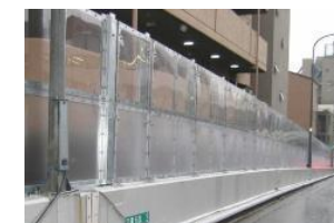
遮音壁・透光板の取替
