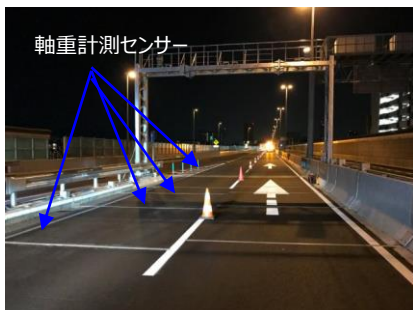
【例】軸重計測装置の新設
