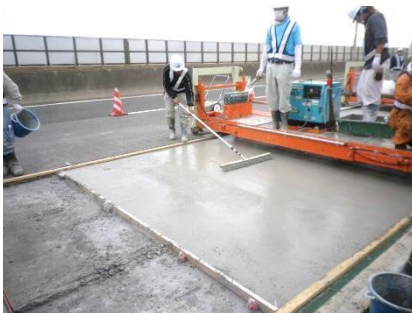
【例】鋼繊維補強コンクリート舗装
