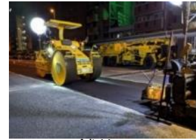
舗装の 全面(部分)打換
