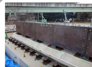
新たな鋼製高欄への取替
