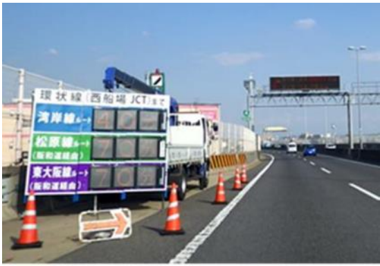
仮設表示板の設置（2018年）： 通行止区間の代替ルートの所要時間を案内
