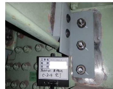
【例】鋼板取替・補強
