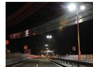
照明柱(標識柱)の取替
