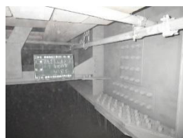
耐久性の高い塗装への更新 （既存塗膜等の除去）
