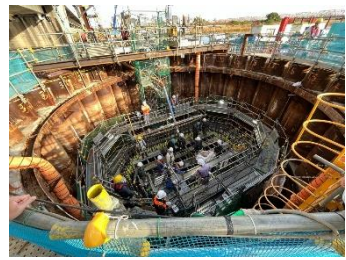
豊崎区間 河川内橋脚の柱コンクリート打設 (淀川左岸線延伸部：建設中)
