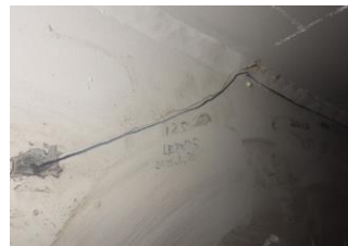
3号神戸線 西宮付近 (2020年6月撮影)
