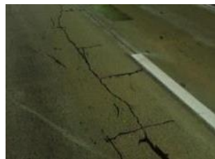
路面のひび割れ
