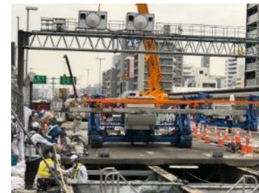
11号守口線 床版の取替
