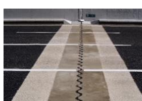
伸縮継手の取替
