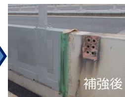
内面の腐食に対して、鋼板補強・部分取替を実施
