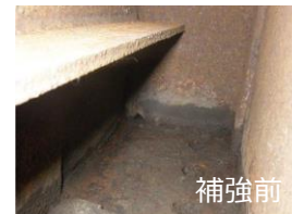
内面の腐食に対して、鋼板補強・部分取替を実施
