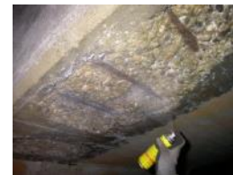
点検時の応急処置 (コンクリートの表面防護)
