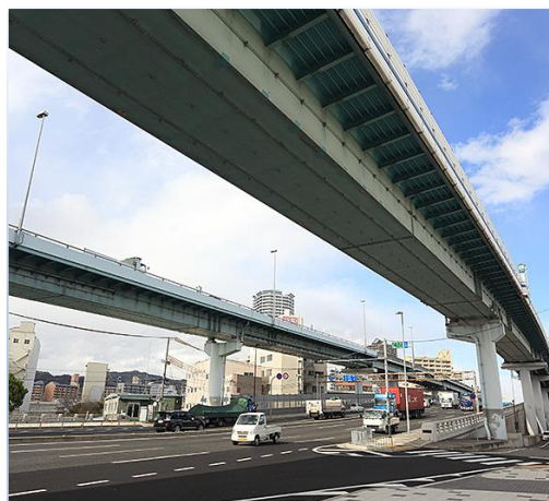
狭い敷地に建設する目的で採用した橋梁構造（薄く軽量な上部工、小さい基礎構造）
