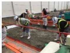
鋼床版上の鋼繊維補強コンクリート (SFRC) 舗装
