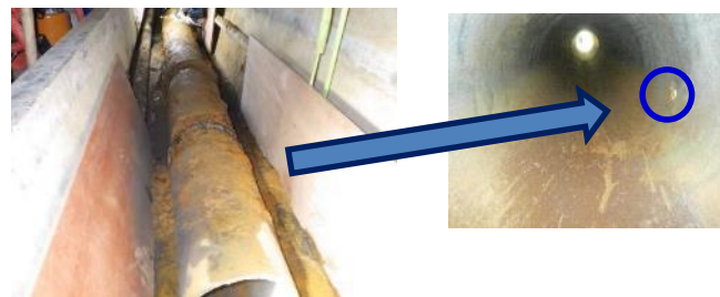
【例】劣化した消火本管の取替
