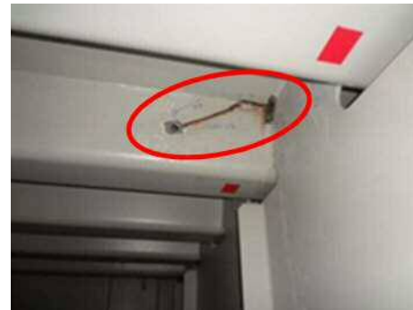
鋼床版き裂損傷状況
