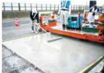
SFRC施工状況
