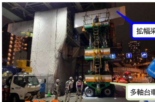
鋼製橋脚梁拡幅の施工状況
