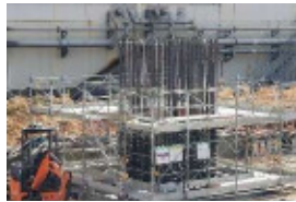
RC橋脚工の実施状況
