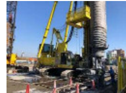
換気所部土留工の実施状況
