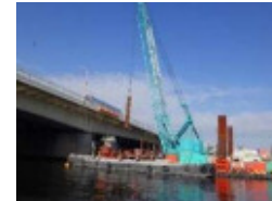
河川内鋼管矢板基礎工の実施状況
